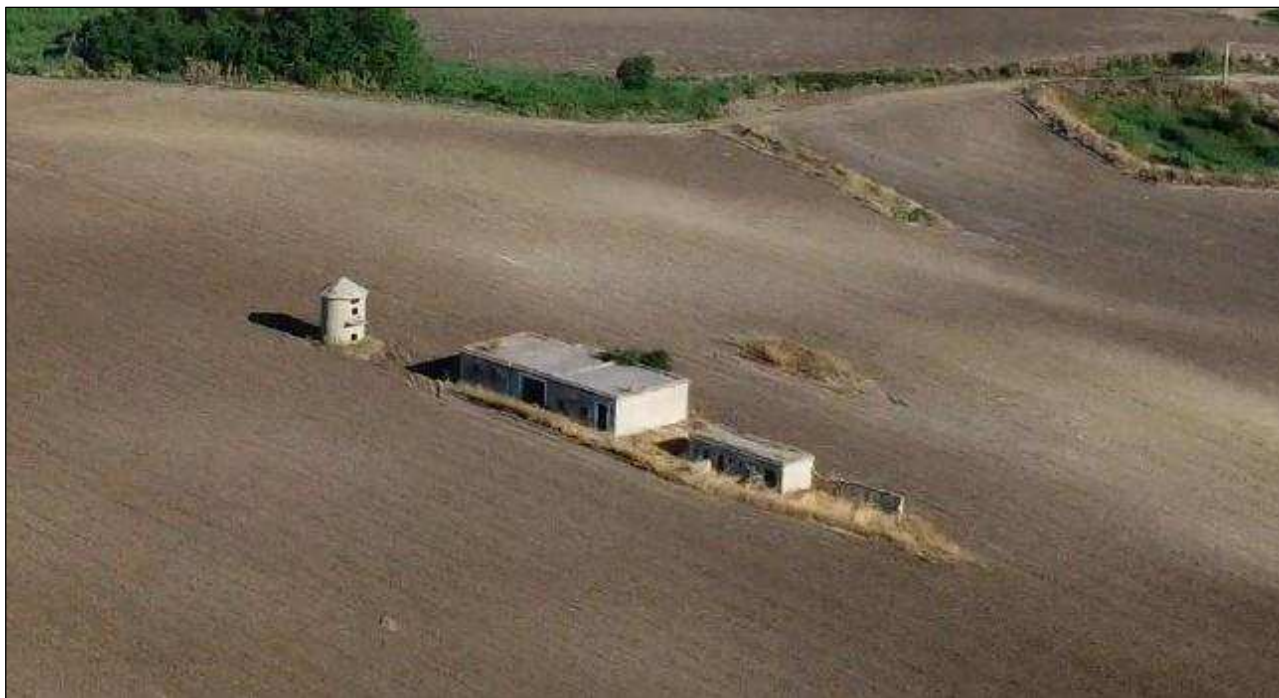
Fig.6 – Masseria con edifici e silos abbandonata
