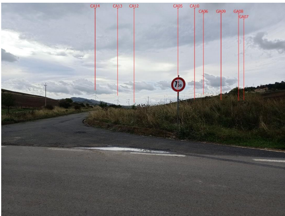
Scatto dal punto P07 (a): ante operam - post operam
