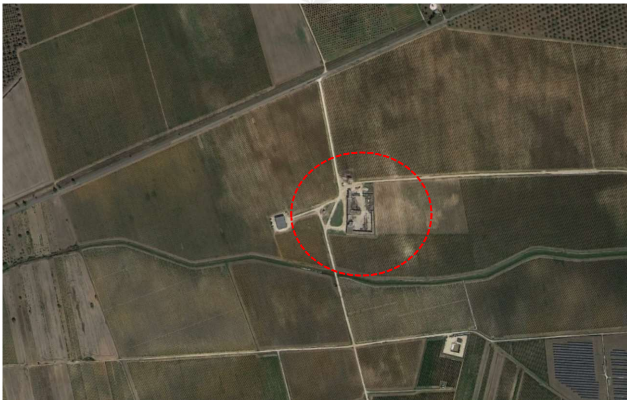
Figura 18: Masseria Lamia (vista dall'alto Google Earth)
