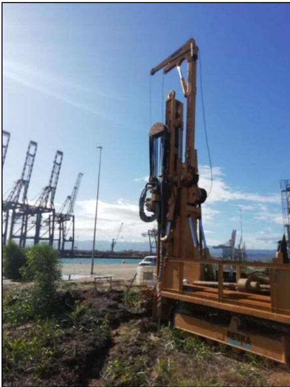
Foto 1 – Ubicazione sondaggio geognostico S5
