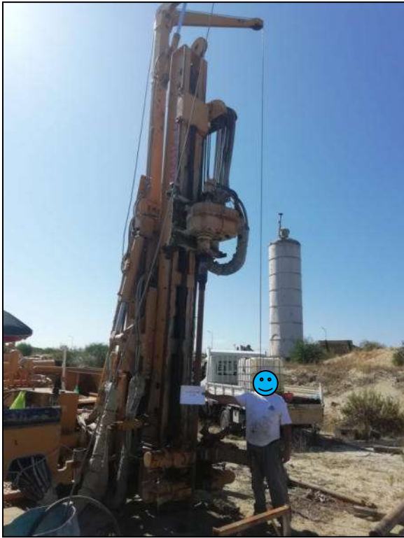
Foto 1 – Ubicazione sondaggio geognostico S3
