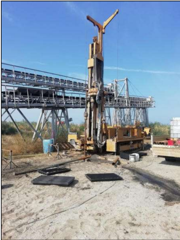
Foto 1 – Ubicazione sondaggio geognostico S2
