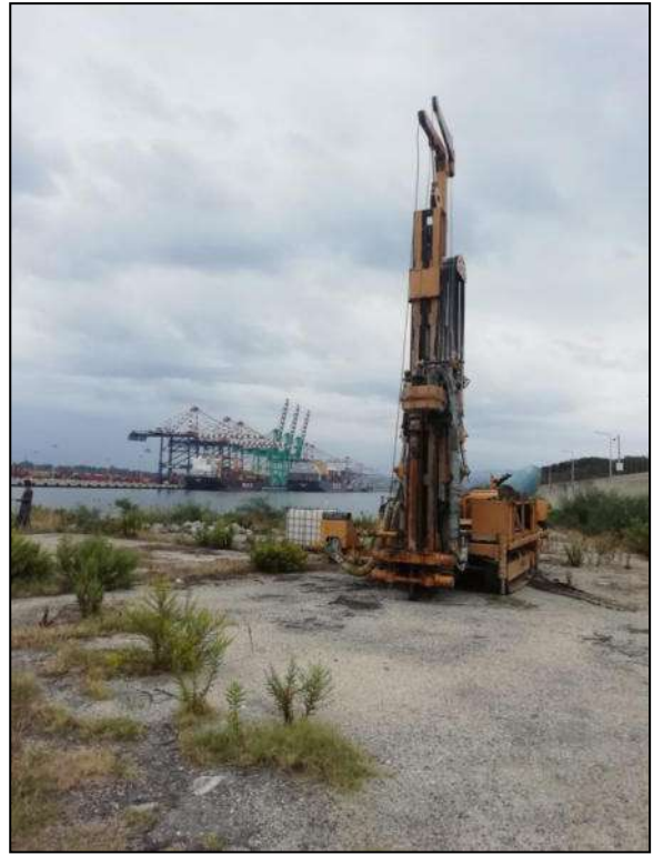
Foto 2 – Ubicazione sondaggio geognostico S4
