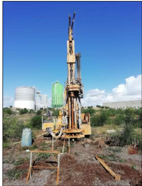
Foto 2 – Ubicazione sondaggio geognostico S5
