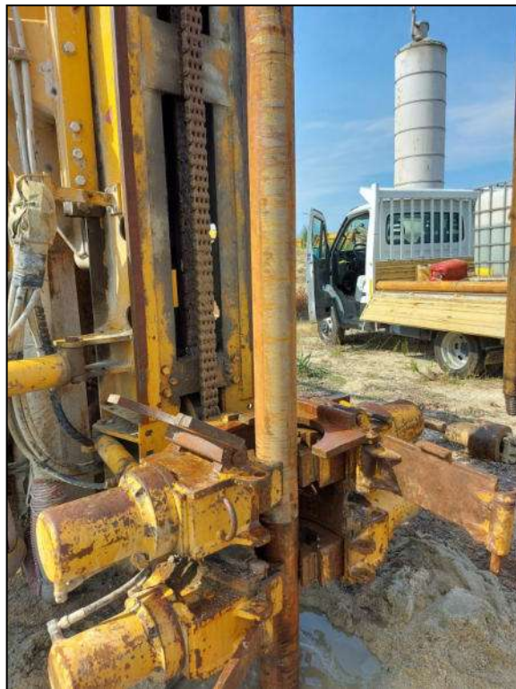
Foto 11 – Utilizzo di tubazione di rivestimento provvisorio
