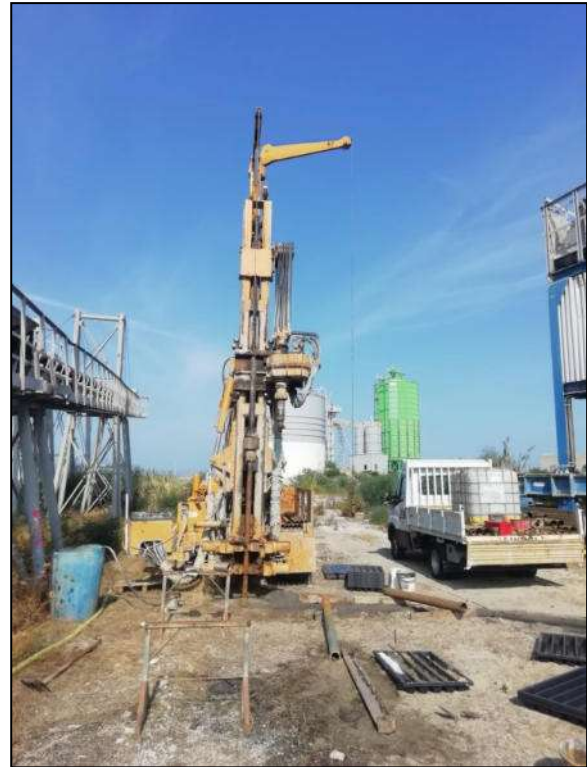
Foto 2 – Ubicazione sondaggio geognostico S2
