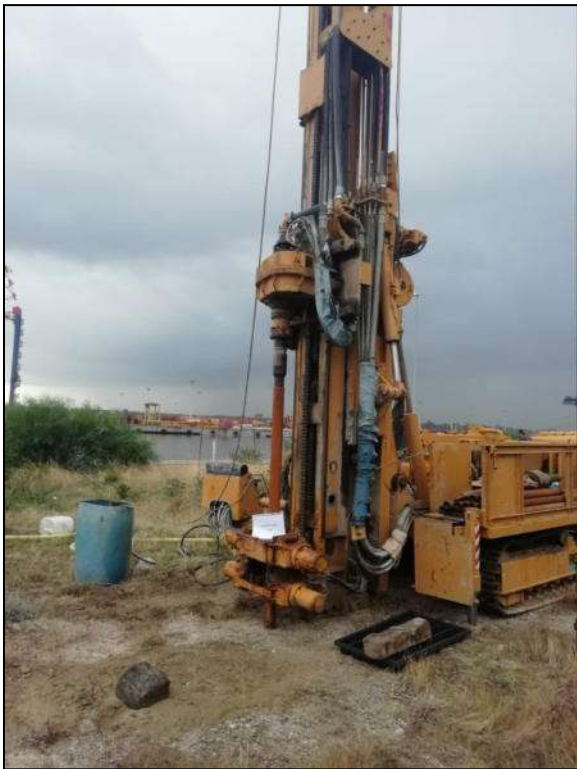
Foto 1 – Ubicazione sondaggio geognostico S6
