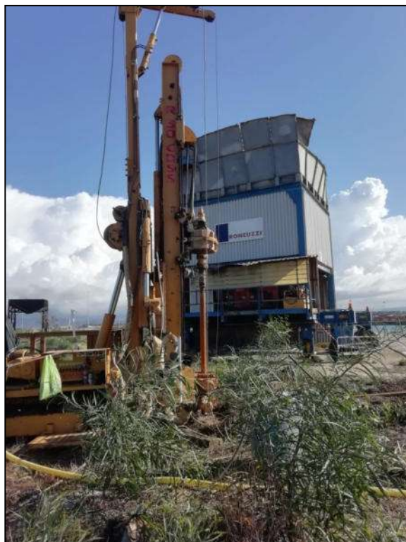
Foto 11 – Utilizzo di tubazione di rivestimento provvisorio
