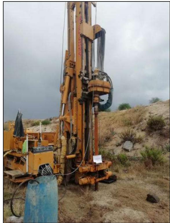
Foto 2 – Ubicazione sondaggio geognostico S6
