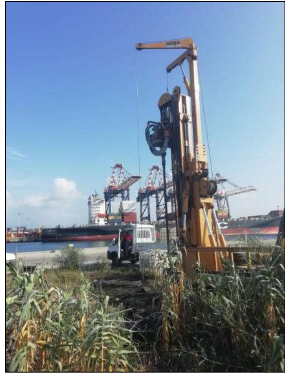
Foto 2 – Ubicazione sondaggio geognostico S1
