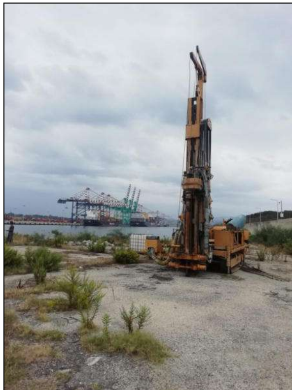
Foto 11 – Utilizzo di tubazione di rivestimento provvisorio
