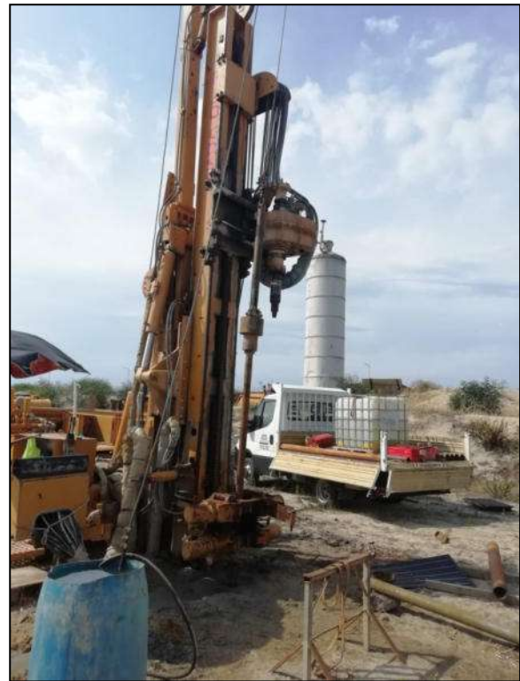
Foto 10 – Fase di esecuzione della prova in foro S.P.T.
