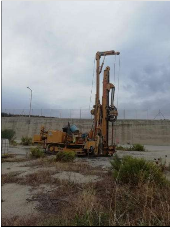
Foto 1 – Ubicazione sondaggio geognostico S4
