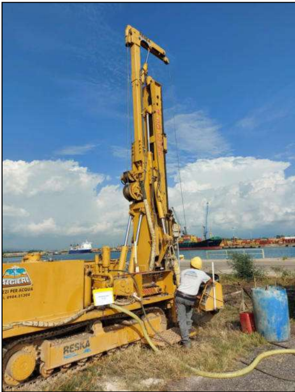
Foto 1 – Ubicazione sondaggio geognostico S1
