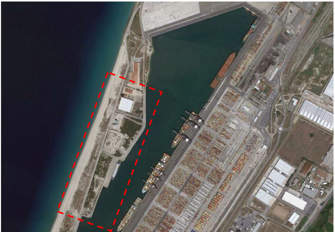
Figura 7 Area interessata dall'intervento. Banchine G-H-L
