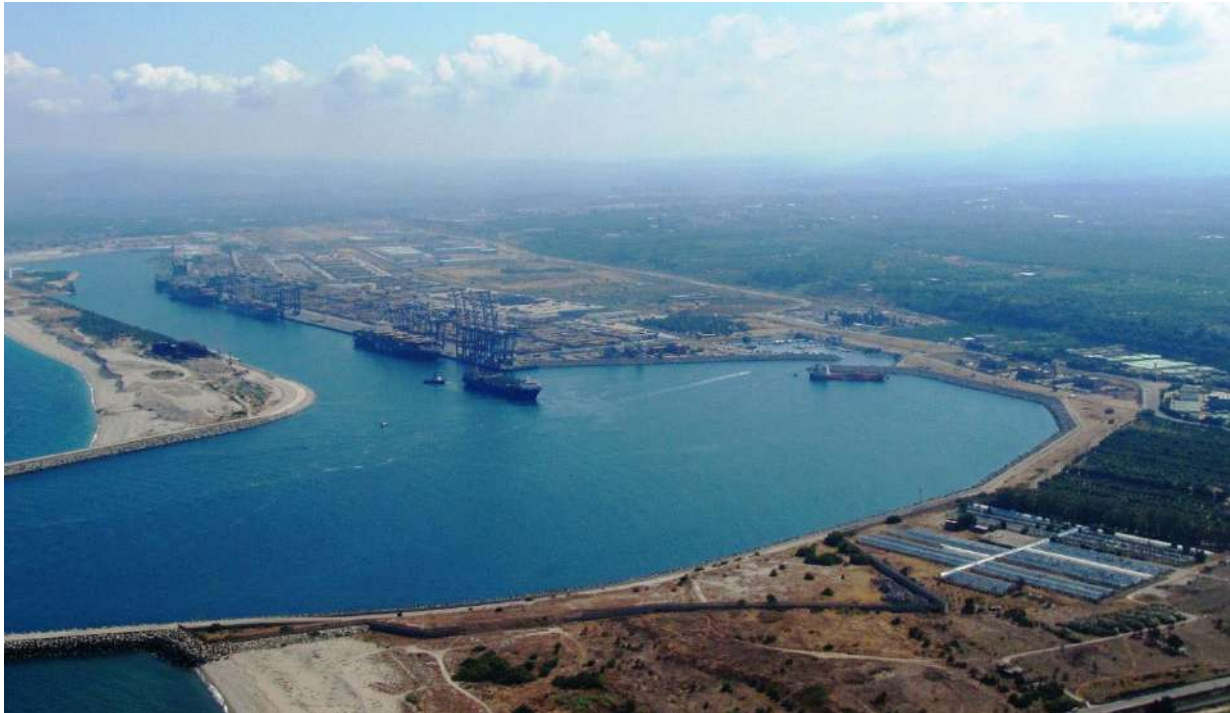
Figura 61 veduta aerea bacino portuale
