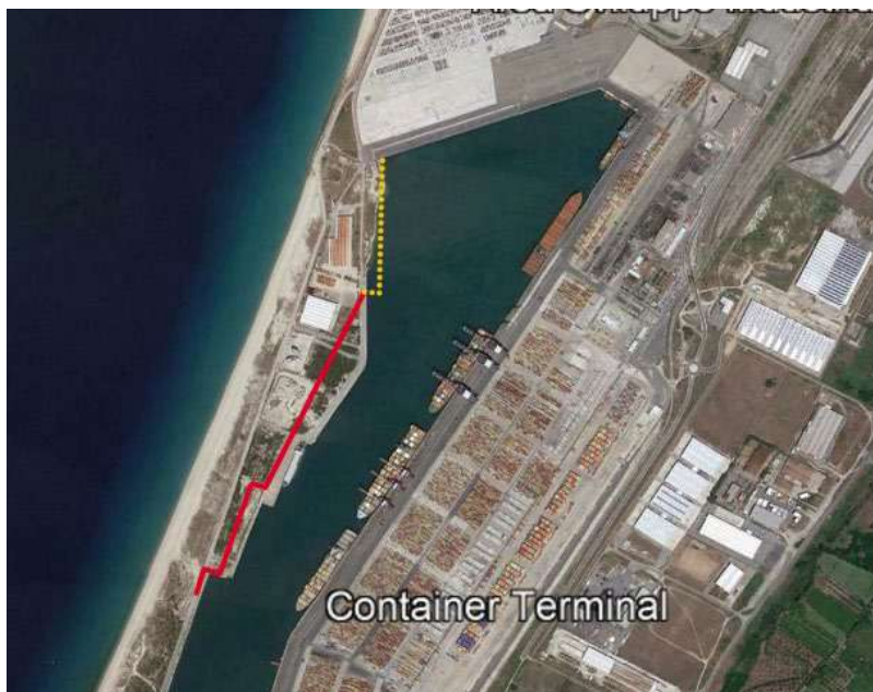
Figura 19 Sovrapposizione su foto aerea dell'intervento. In rosso l'intervento che interessa i tratti G-H-I
