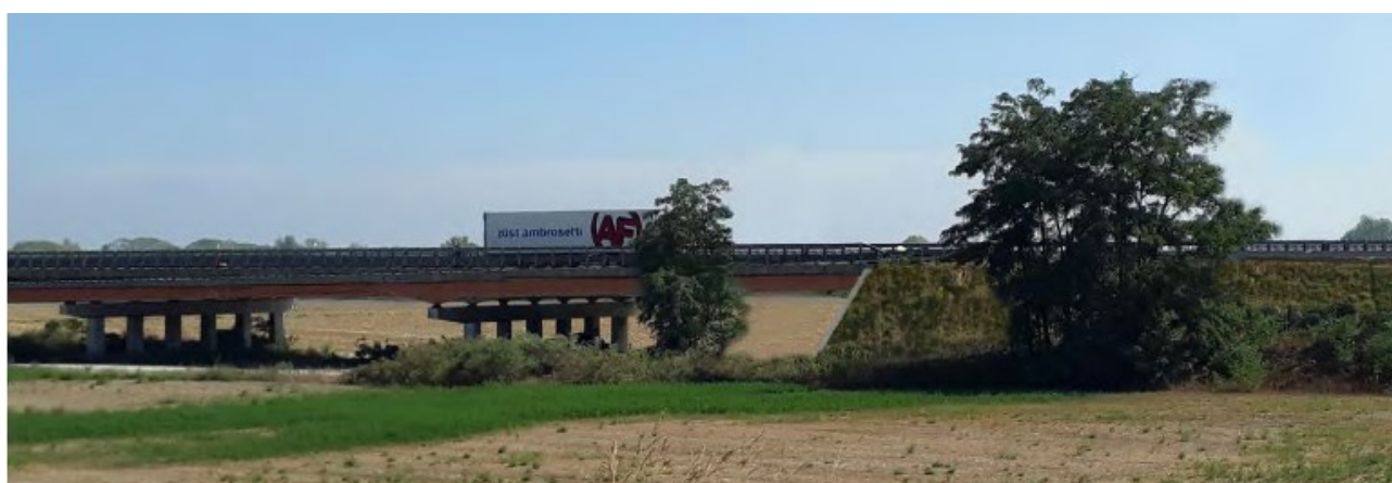
Figura 3: Vista da Castelvetro P.no: vista del tratto autostradale di transizione tra rilevato e viadotto: in alto lo stato ante operam, in basso lo stato post operam. Fonte "Studio Ambientale" allegato alla Lista di controllo.
