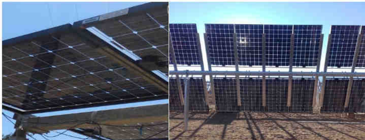
Rappresentazione indicativa struttura sostegno e moduli fotovoltaici
