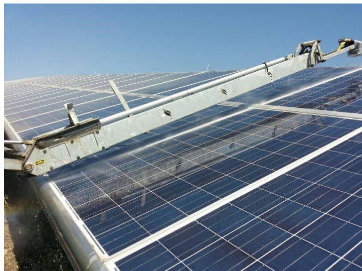
Figura 16 – Operazioni di pulizia moduli effettuate con sistema atomizzatore con uso esclusivo di acqua.
