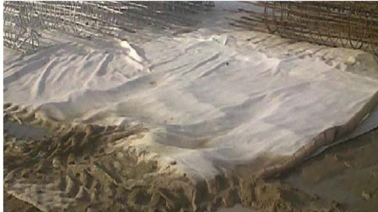
*Figura 1 - Posa di teli impermeabili nelle aree fisse di cantiere*
