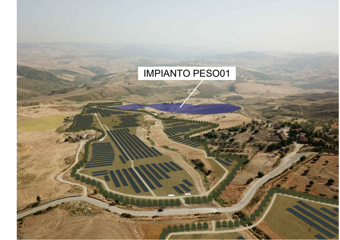
Punto di ripresa n°4 post operam con cumulo impianto fotovoltaico "PESO01".
