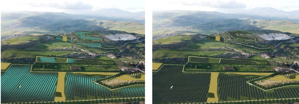
Figura 33 - Rendering dell'impianto “Garisi” con moduli in silicio policristallino (foto a sinistra) e impianto con moduli con tecnologia antiriflesso in silicio monocristallino che saranno installati (foto a destra)
