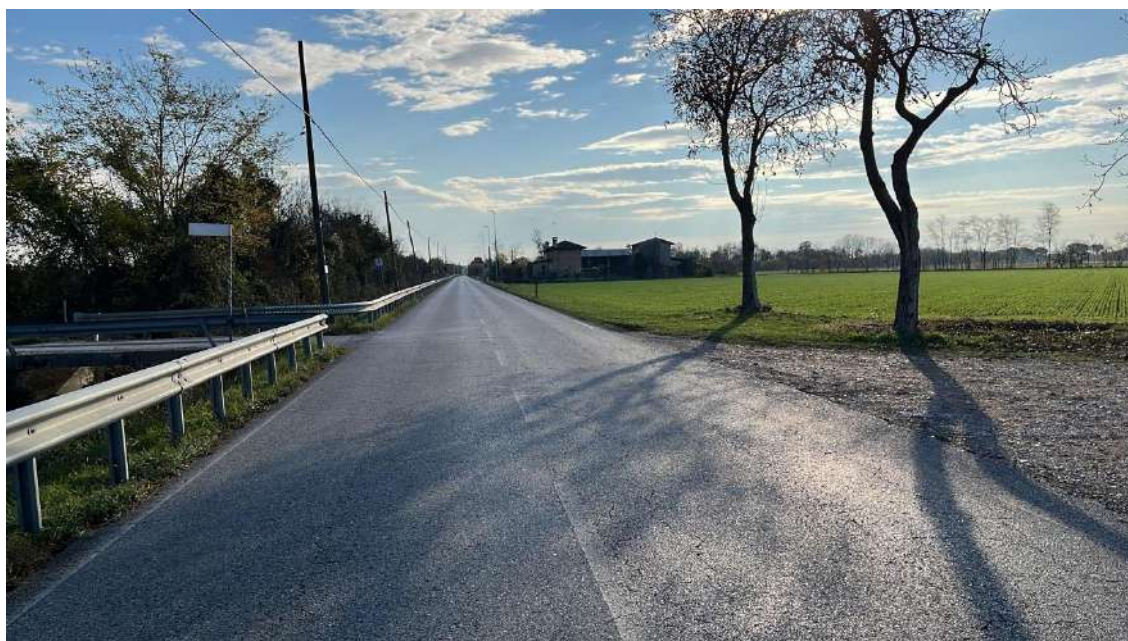
Foto 8bis – SP71 – Attraversamento tombino stradale
