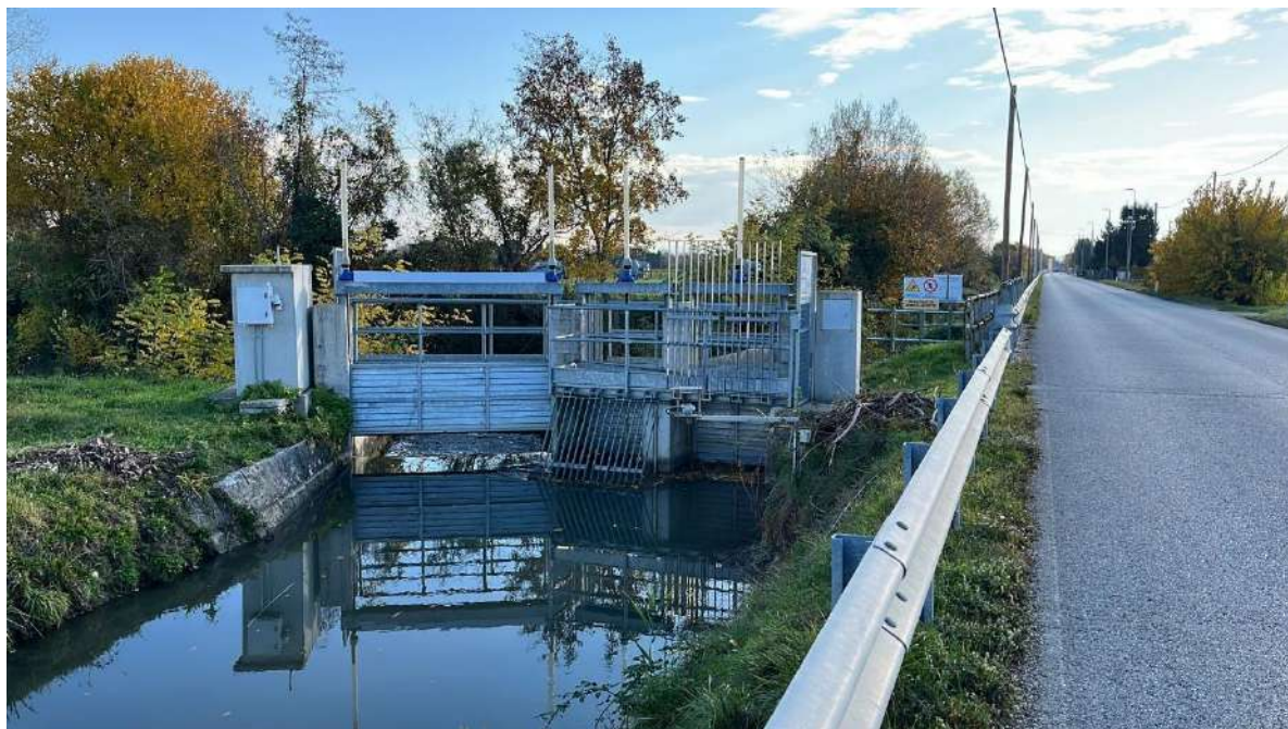
Foto 10quater - Strada Provinciale 71 – attraversamento canale – Incrocio tra la Roggia Di Palma e la Roggia Brentana
