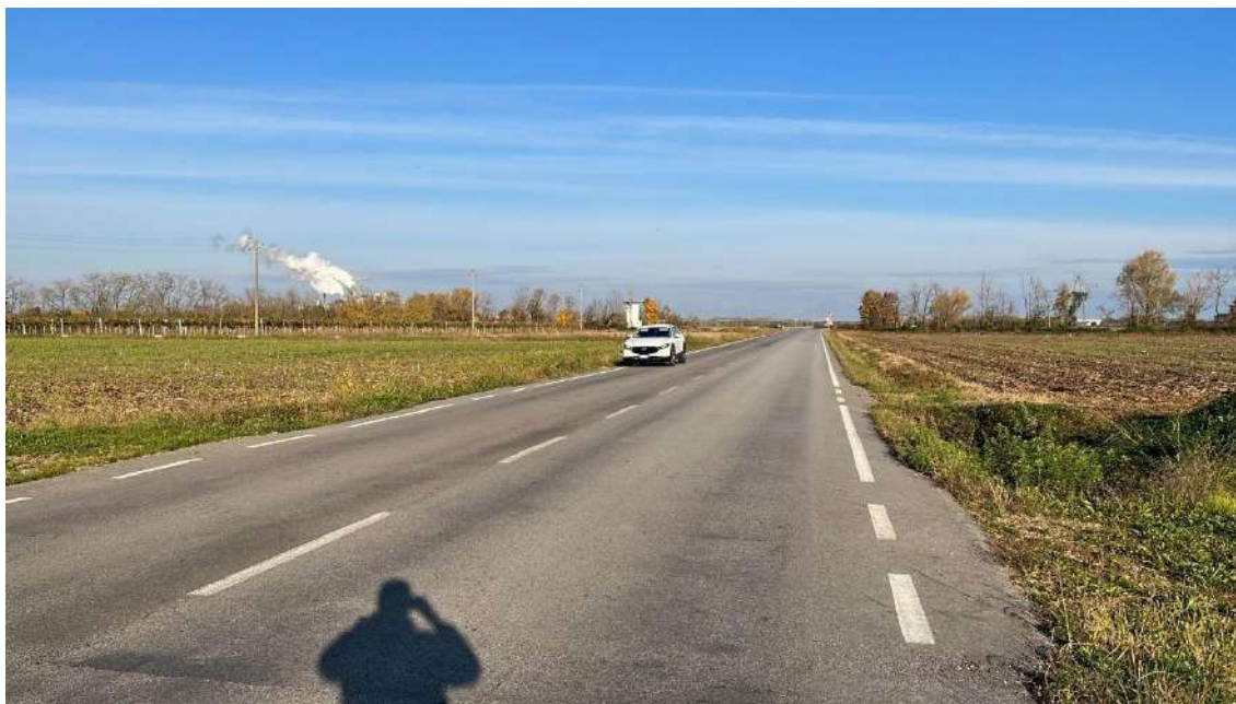
Foto 3bis – Attraversamento tombino stradale
