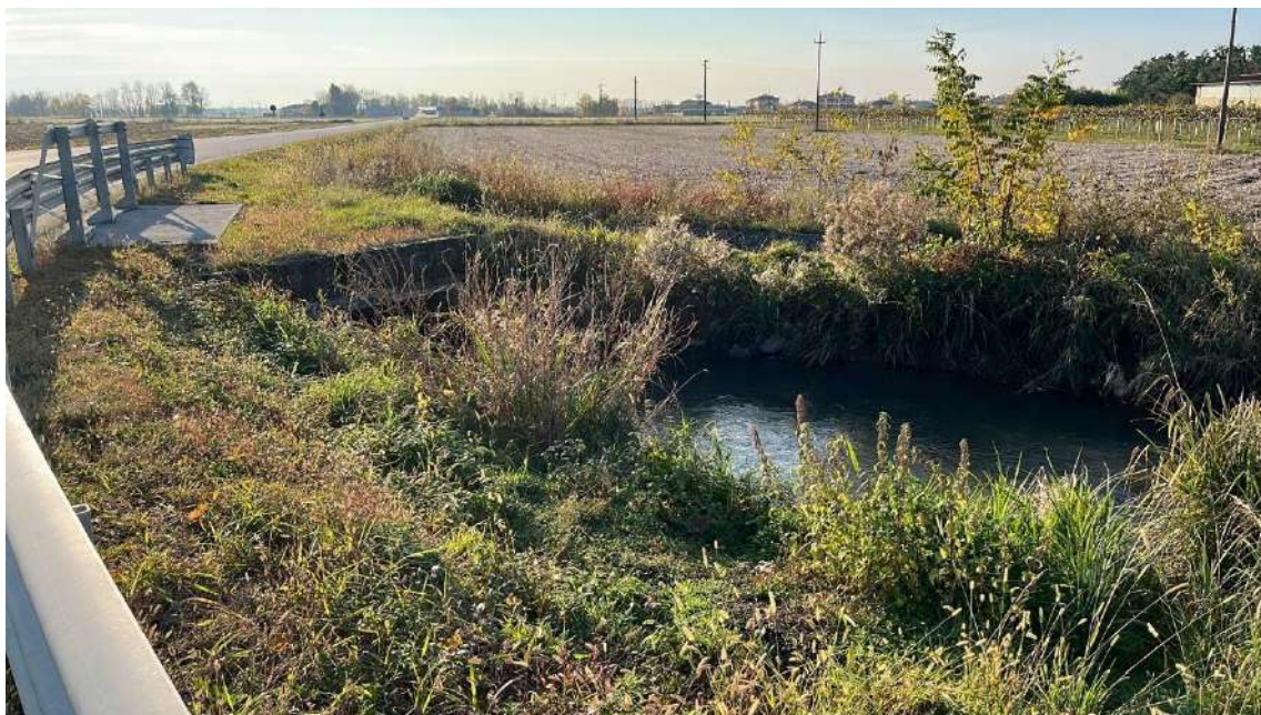
Foto 2 – Particolare – Attraversamento Roggia Palmanova
