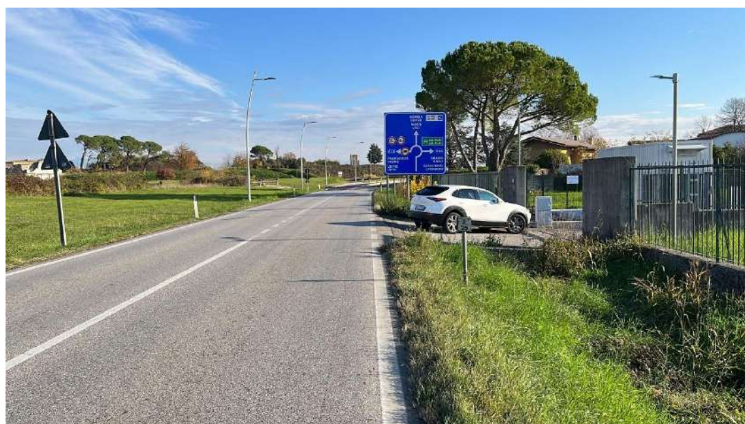
Foto 23 – SR252 – Ingresso cabina primaria "Palmanova"
