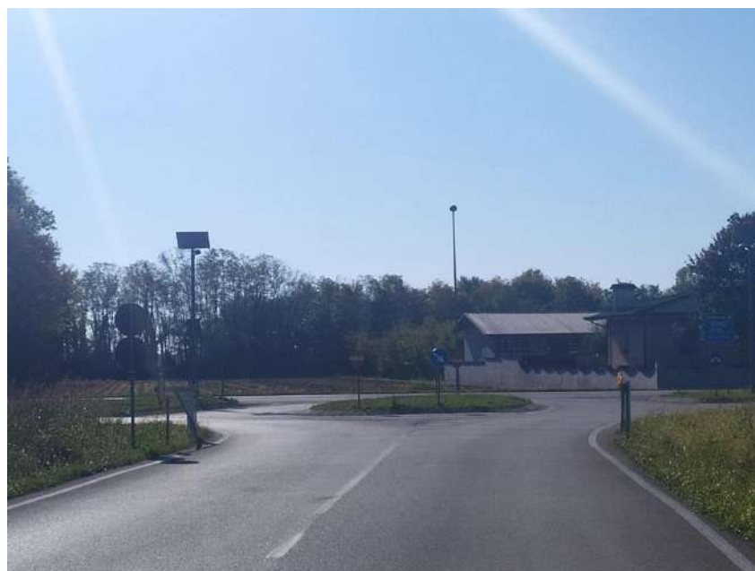
Foto 5 - Strada esistente – Incrocio con via G. Verdi
