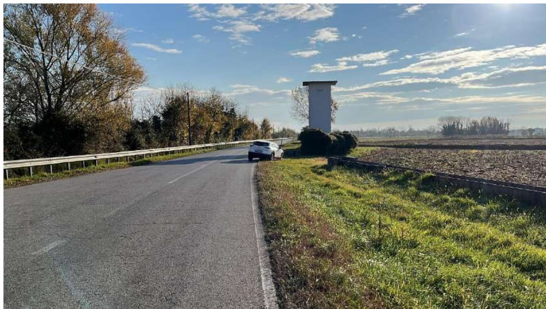
Foto 8 - Strada Provinciale 71 – Particolare attraversamento tombino stradale
