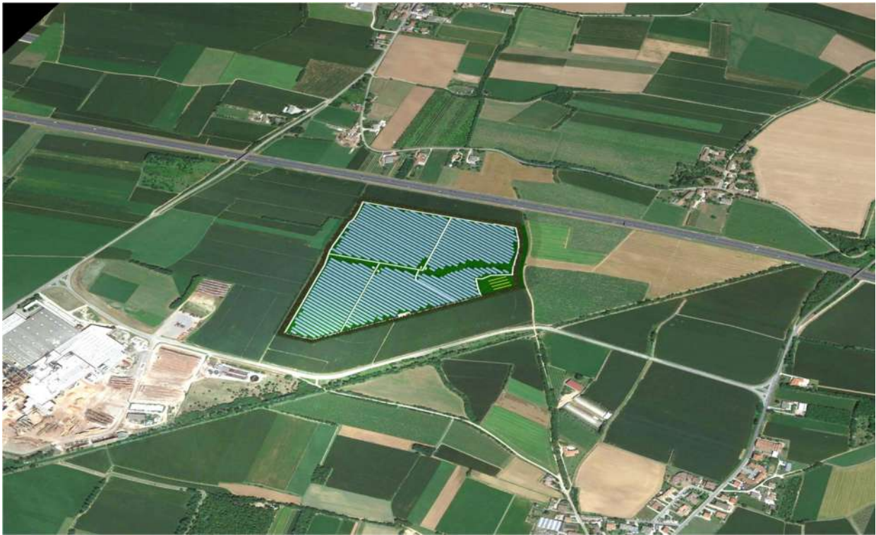
Figure 4-12. Veduta generale dell'intervento
