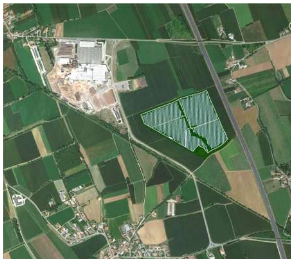
Figure 4-10. Veduta generale dell'intervento
