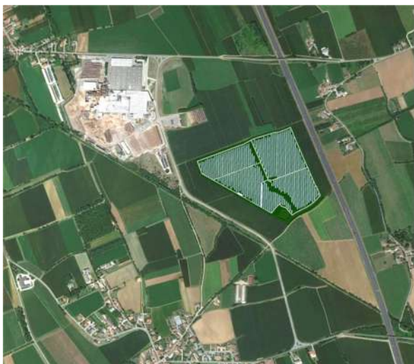
Figure 2-2. Veduta generale dell'intervento
