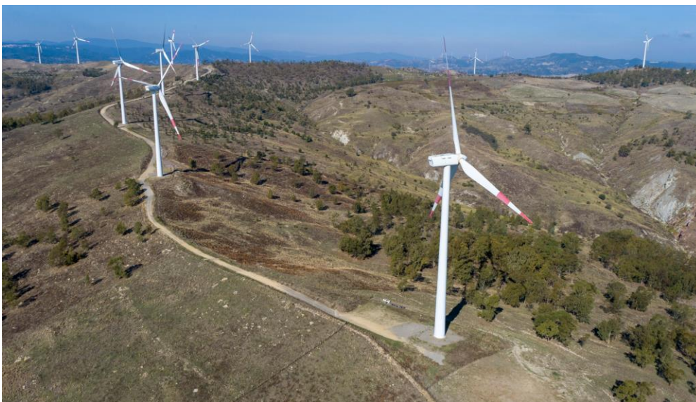
Foto 2 Foto dell'attuale impianto di Melissa Strongoli
