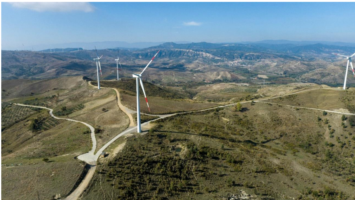
Foto 1 dell'attuale impianto di Melissa San Francesco
