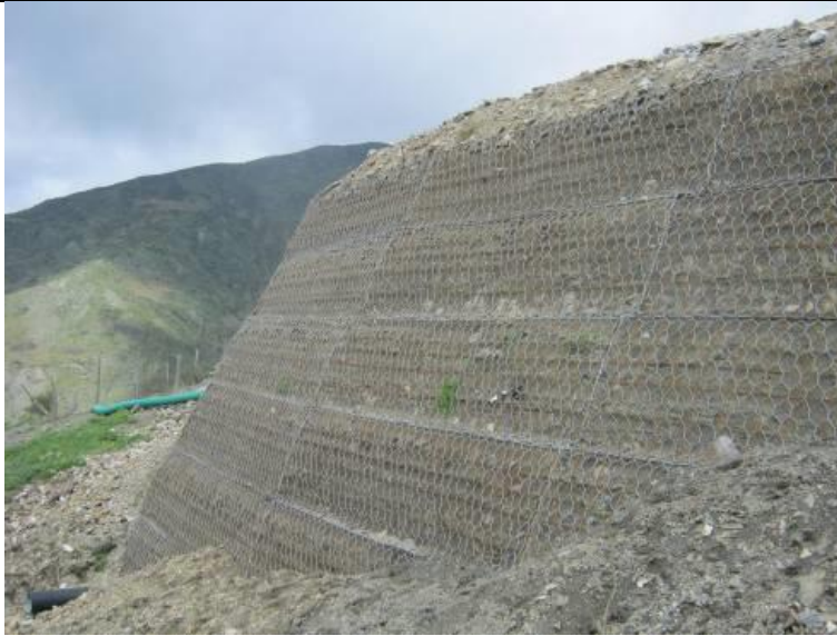
Foto 3 Esempio di opera in terre rinforzate - Fonte HE
