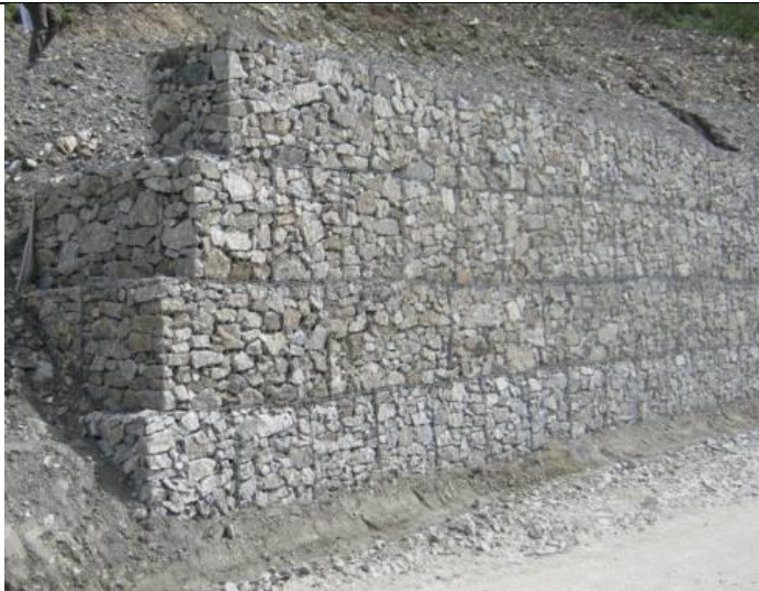
Foto 4 Esempio di opera in gabbioni - Fonte HE
