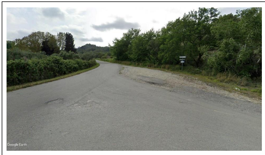
Fig. 17 – Incrocio tra le strade comunali di C.da Monaco e C.da Maremonti
