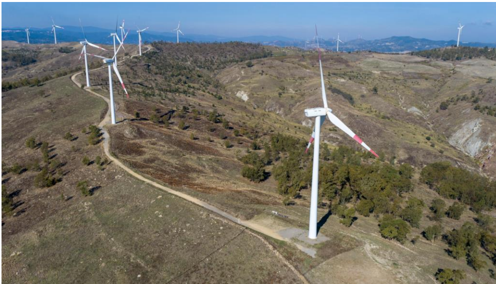
Foto 2 Foto dell'attuale impianto di Melissa Strongoli
