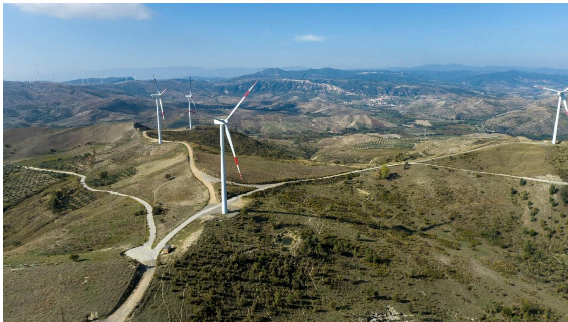
Foto 1 dell'attuale impianto di Melissa San Francesco
