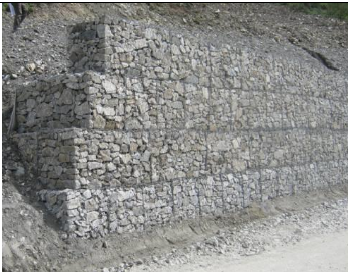
Foto 4 Esempio di opera in gabbioni - Fonte HE
