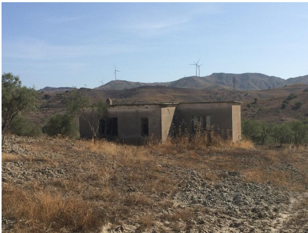
Figura 4-7: Struttura monitorata per la ricerca dei rifugi estivi dei chiroterri
