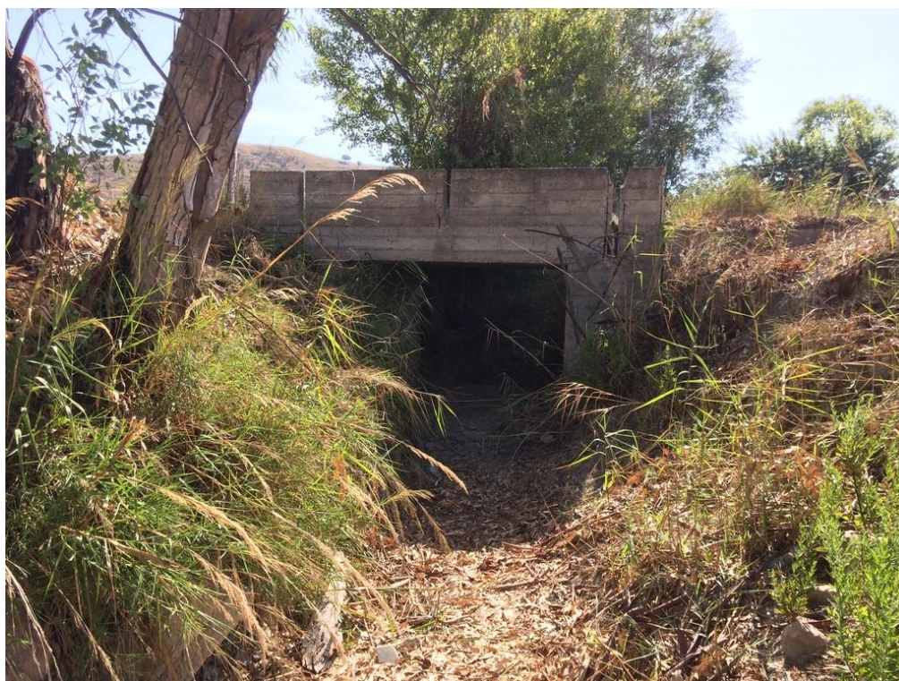
Figura 4-8: Canale monitorato durante le ispezioni
