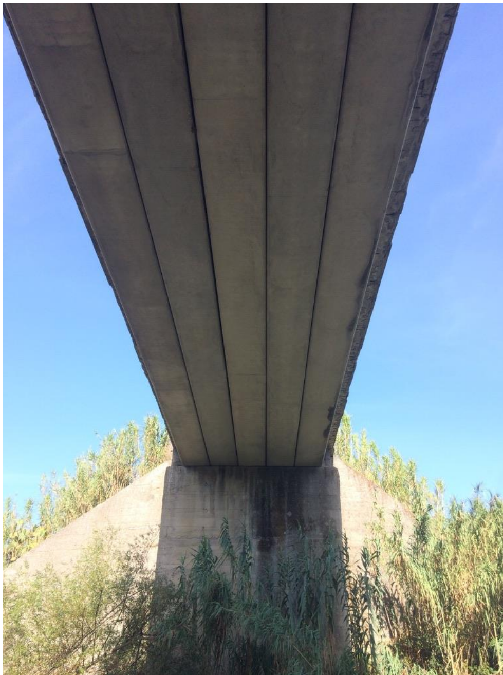
Figura 4-6: Dettaglio di uno dei viadotti monitorati per la ricerca dei rifugi estivi dei chiroteri
