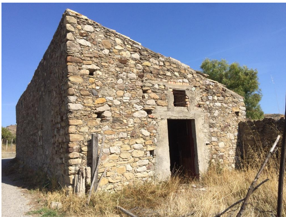
Figura 4-3: Struttura monitorata per la ricerca dei rifugi estivi dei chiroterri
