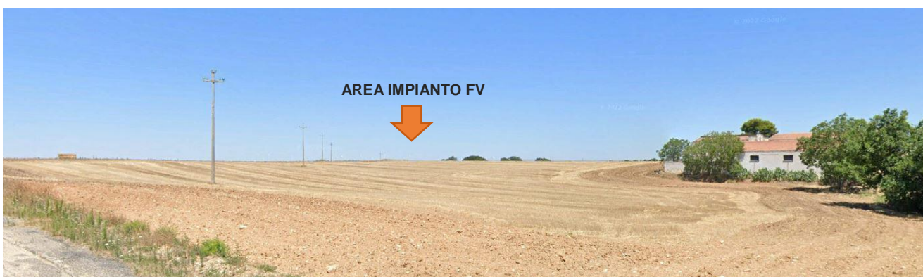
Panoramica dal Punto 2 – post operam
