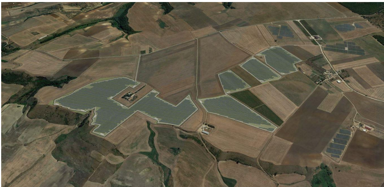
Panoramica B – Vista Ovest
