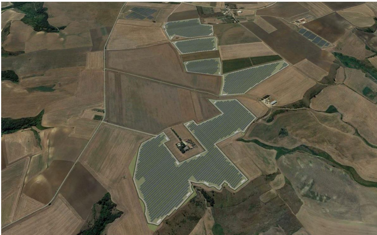
Vista A – Lato Nord-Ovest
