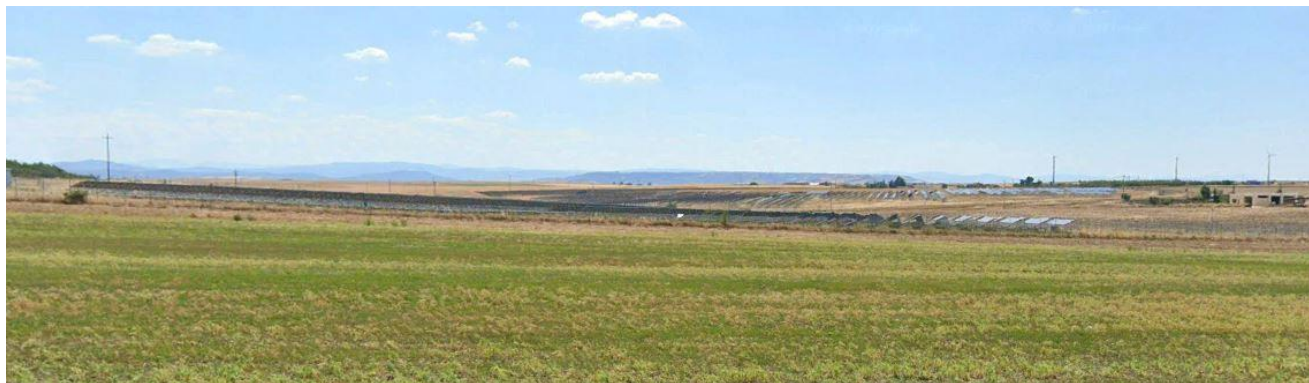
Figura 15-9: Impianti fotovoltaici già realizzati a sud-est dell'area di intervento
