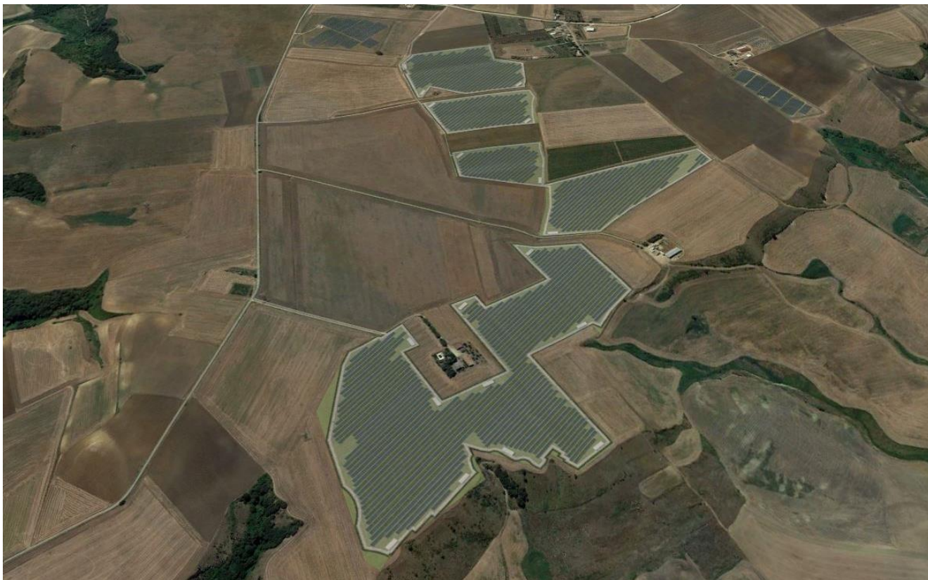
Vista A – Lato Nord-Ovest
