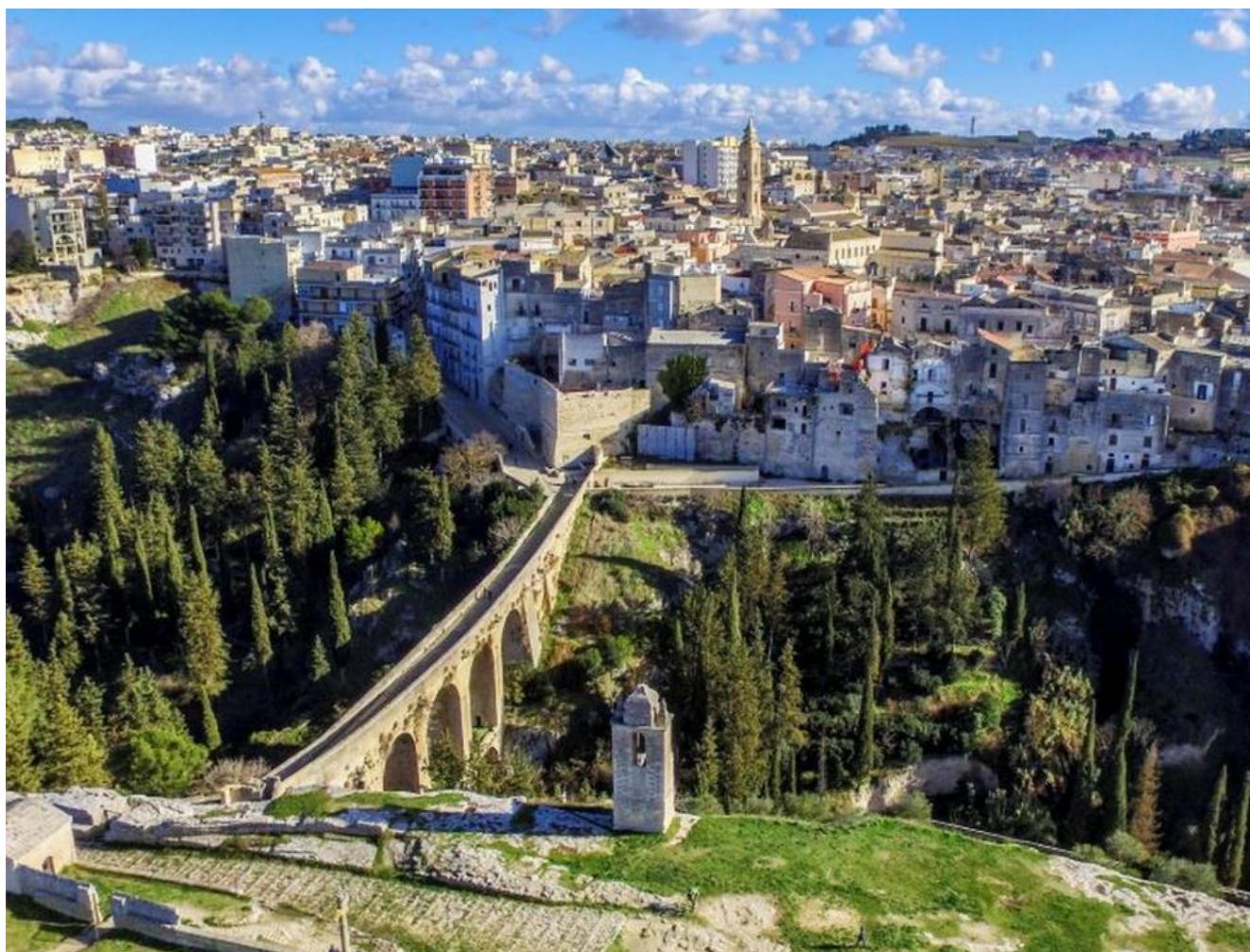
Figura 14-4: Panoramica di Gravina di Puglia
