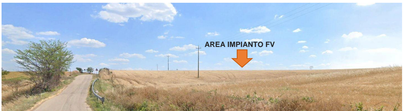
Figura 15-7: Vista da P5 (Masseria Zingariello) verso l'area di impianto
