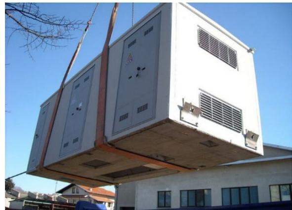
Figura 38: Fornitura e posa in opera delle cabine e dei locali tecnici
