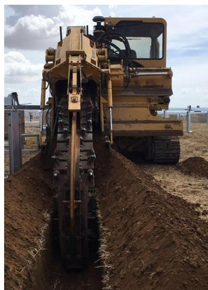
Figura 37: Esempio di realizzazione di cavidotto interrato su strada asfaltata e terreno vegetale
