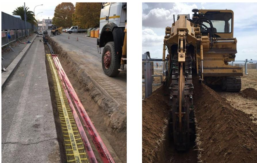
Figura 13: Esempio di realizzazione di cavidotto interrato su strada asfaltata e terreno vegetale
