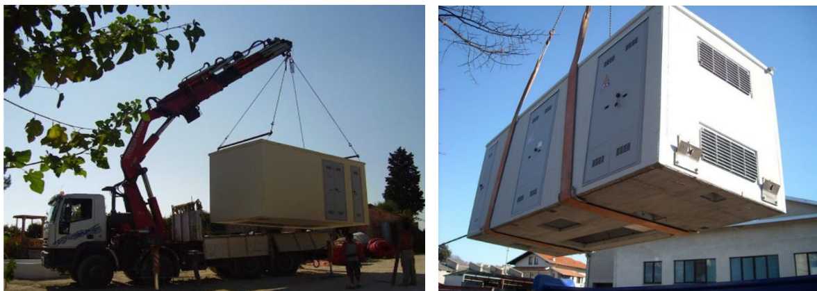
Figura 3: Rimozione delle cabine di raccolta e delle Power Station
