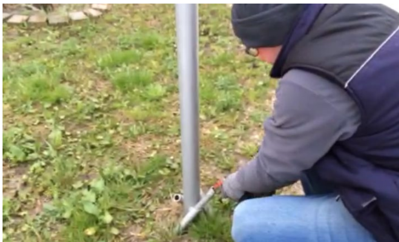
Figura 2: Rimozione degli elementi di ancoraggio delle strutture
