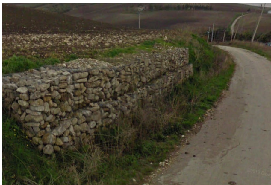
Figura 64: Muretto lungo la Contrada Montalvino
