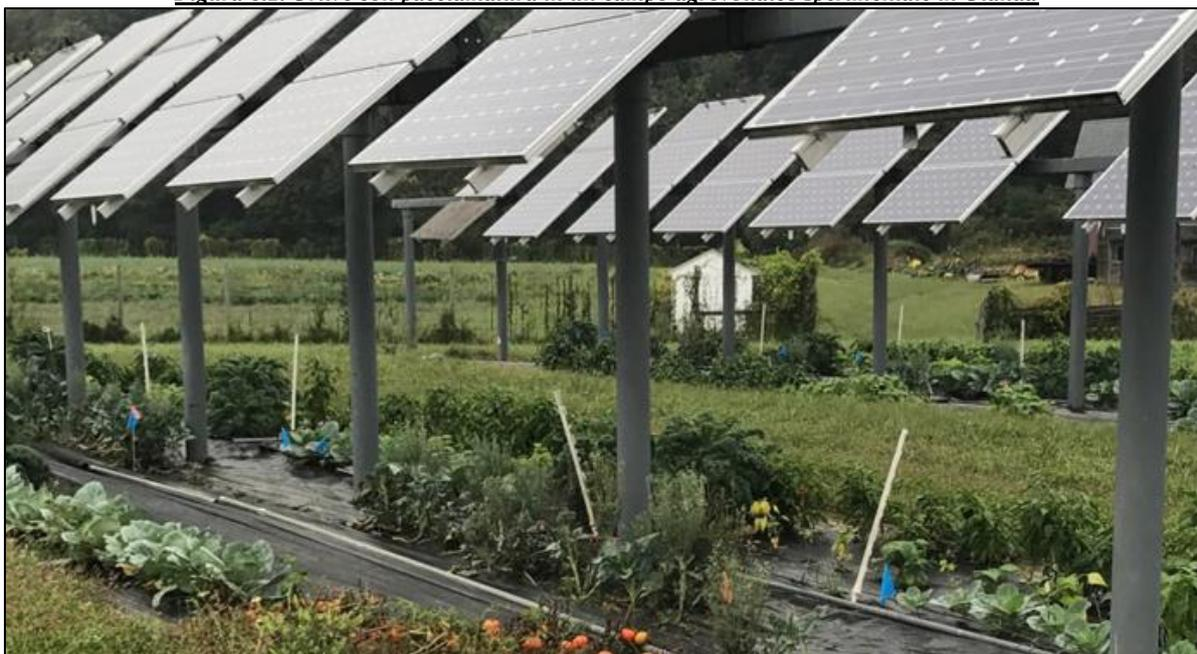
*Figura 6.2. Agrivoltaico a moduli fissi con struttura a falde in Cina, in un campo coltivato a bacche di Goji*
