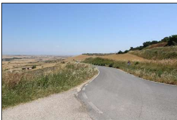
Località San Antonio, tratto di cavidotto lungo la SS 160 visto da SW
