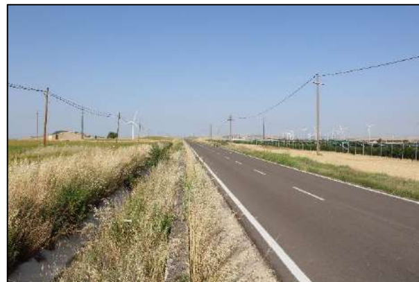
Località Monsignore, tratto di cavidotto lungo la SP 124 visto da W
