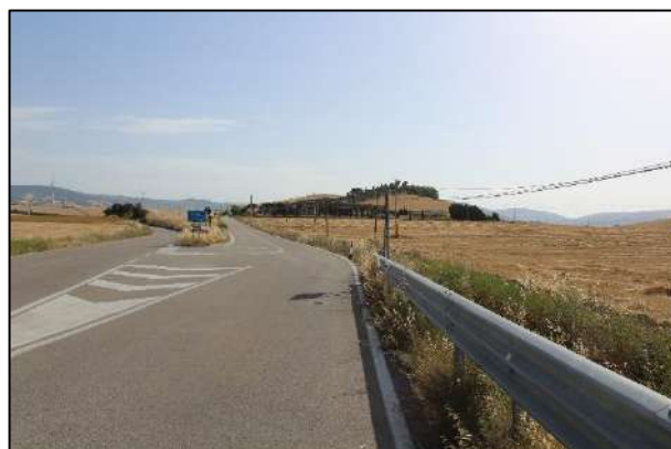
Località Masseria Serra dei Bisi, tratto di cavidotto lungo la SP 124 visto da NE
