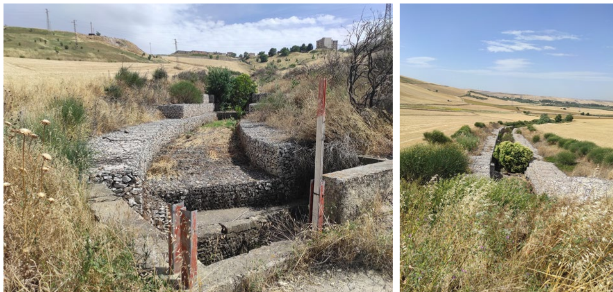
Figura 5-6 – Particolare della sistemazione idraulica di una linea di impluvio
