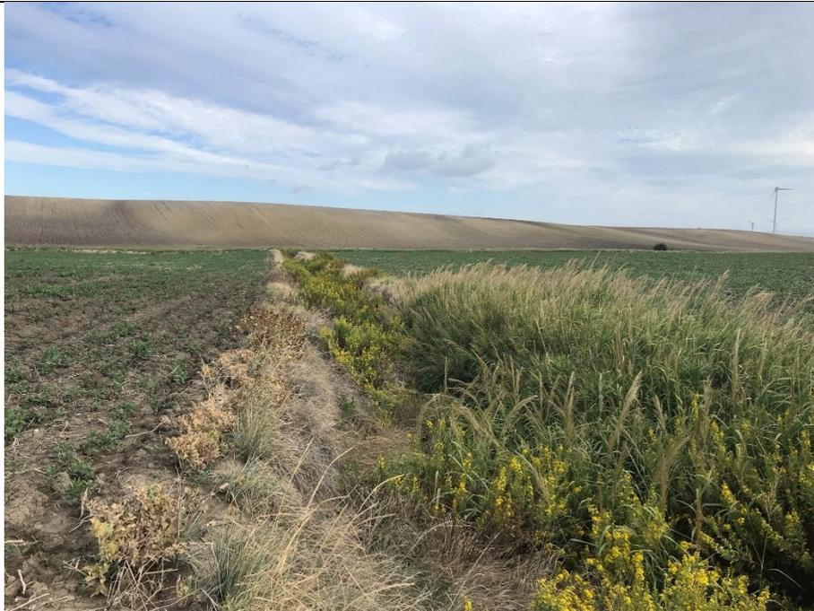
*Figura n. 6. Canale di drenaggio - tratto terminale. Il tratto risulta integro ma invaso da vegetazione che ne limita l'efficienza idraulica*
