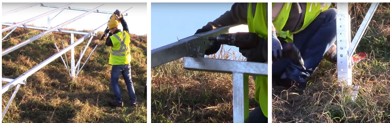
Figura 34: Posa in opera delle barre di ancoraggio e delle strutture e sistema di regolazione
