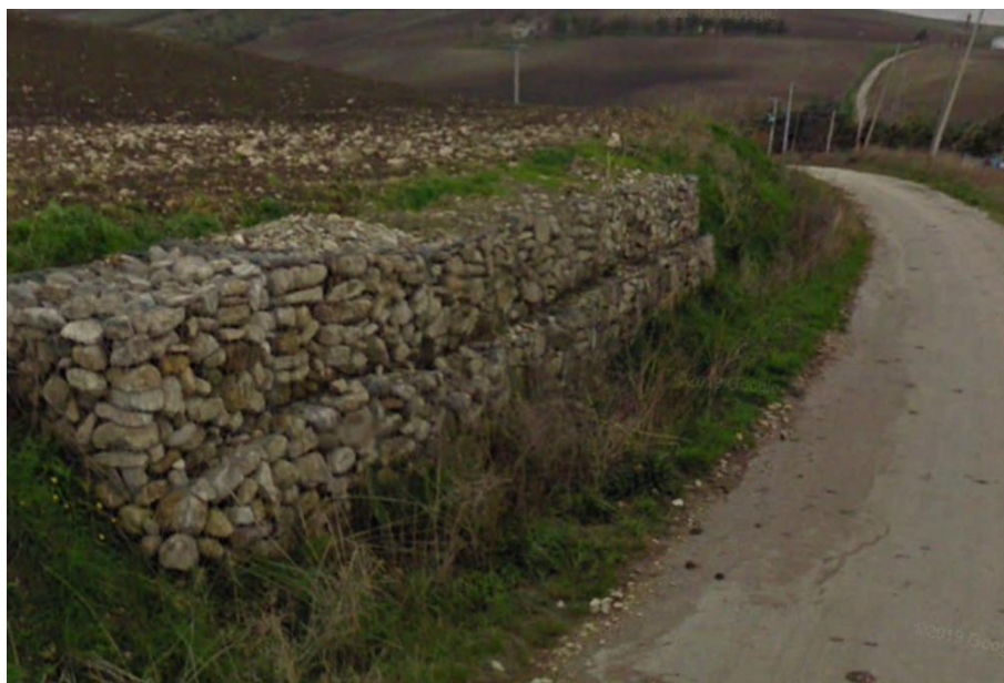
Figura 102: Muretto lungo la Contrada Montalvino
