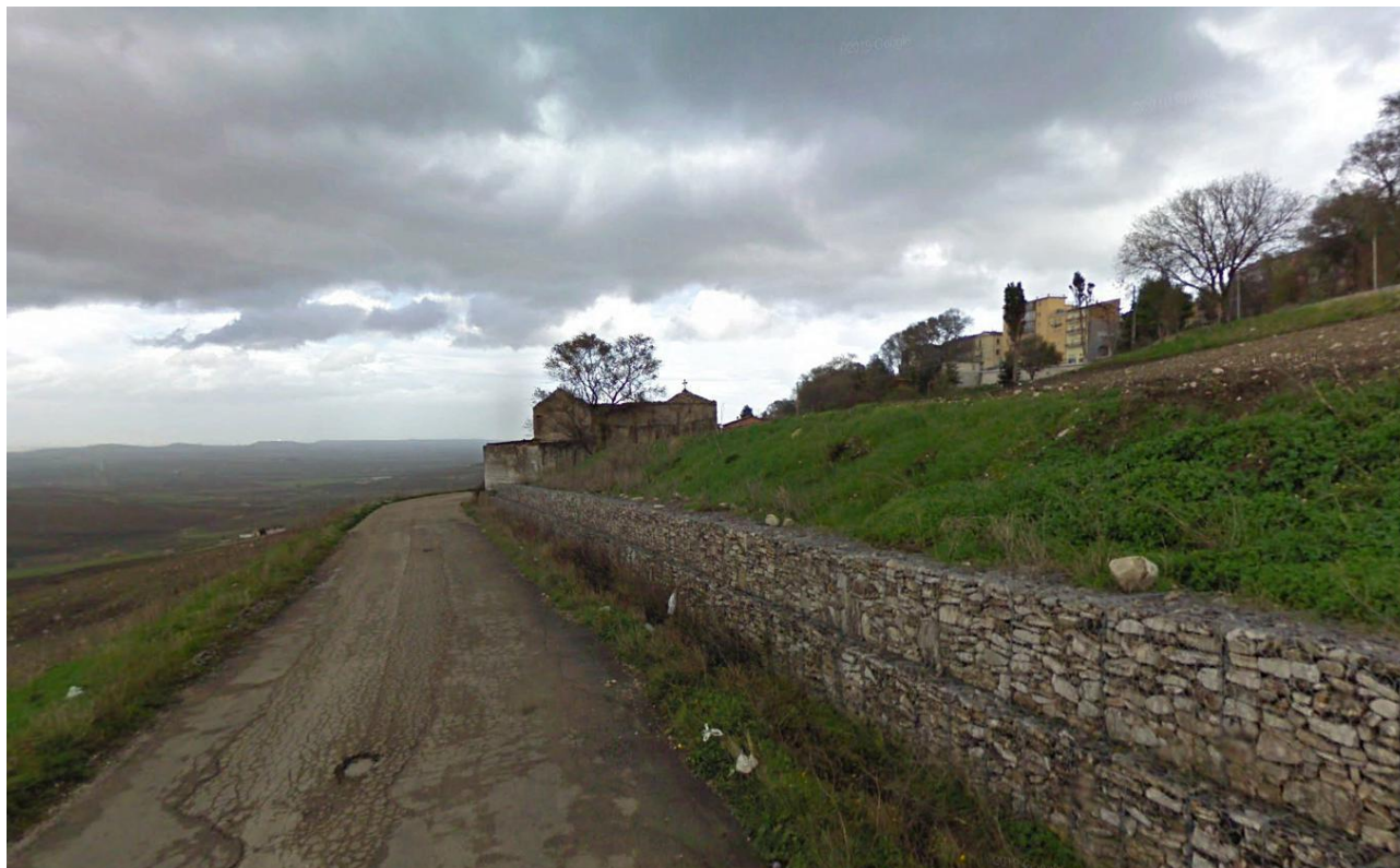
Figura 73 – Opere di contenimento controterra con gabbionate.
