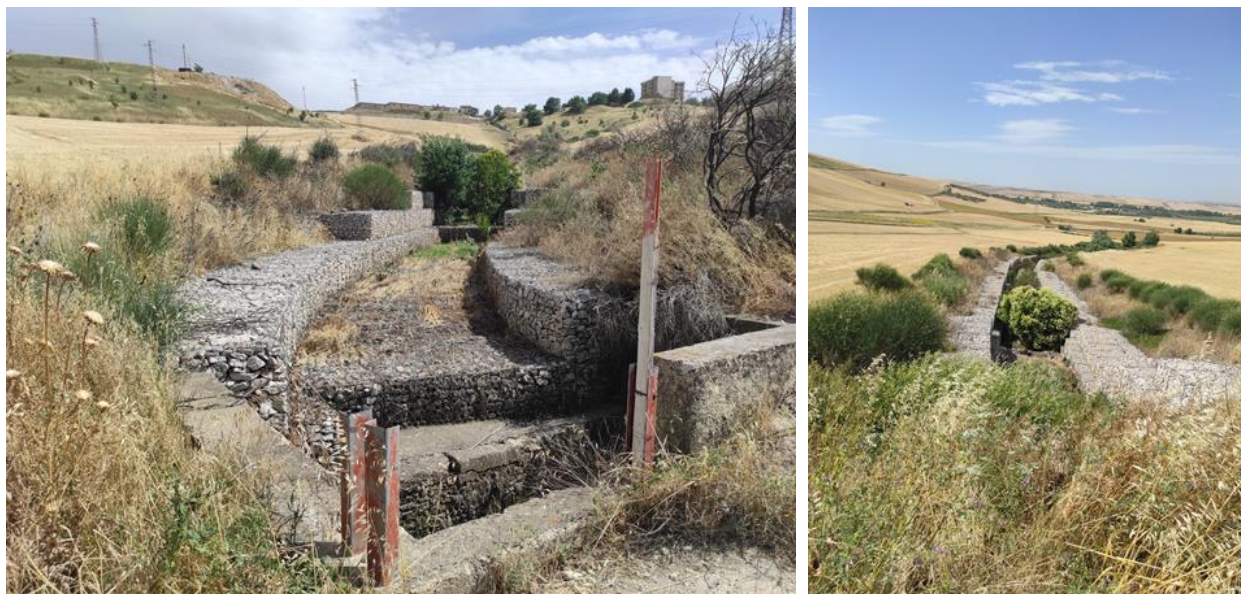
Figura 70-71 – Particolare della sistemazione idraulica di una linea di impluvio
