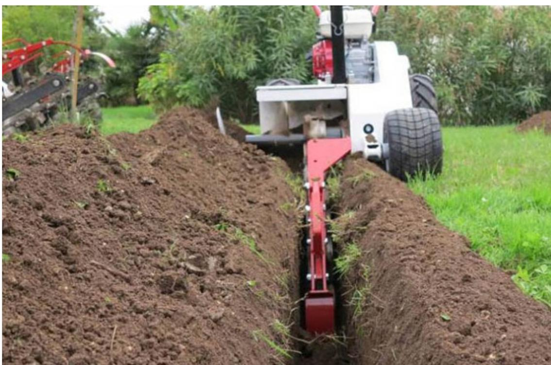
**Figura 22: Particolare operazioni di scavo a sezione ristretta.**
