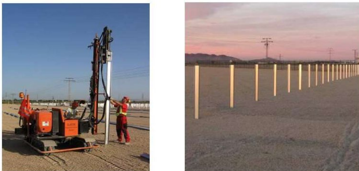
Figura 3 - Esempio pali di fondazione infissi nel terreno
