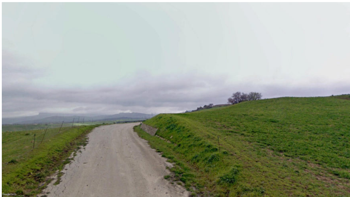
Vista 13- Stato ante-operam
