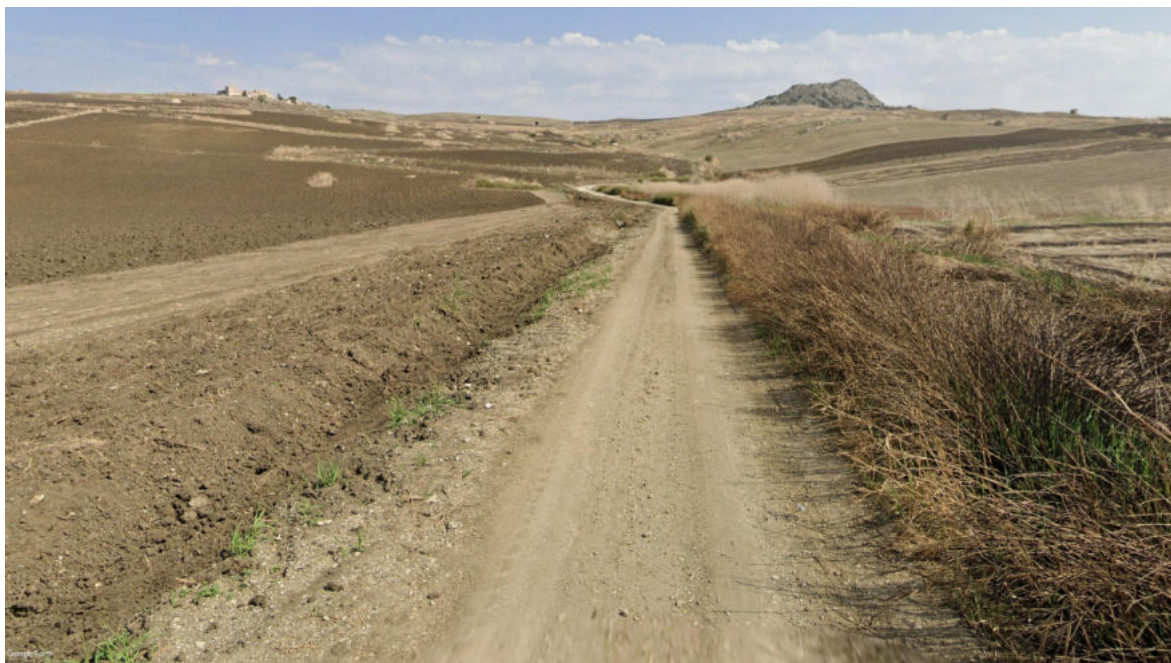
Vista 5- Stato ante-operam
