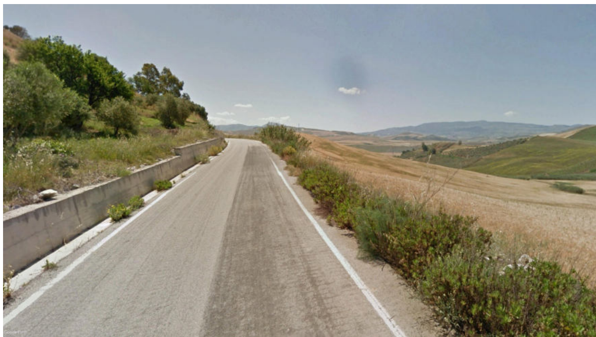
Vista 11- Stato ante-operam
