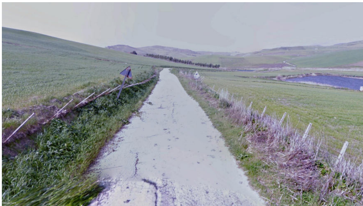
Vista 4- Stato ante-operam
