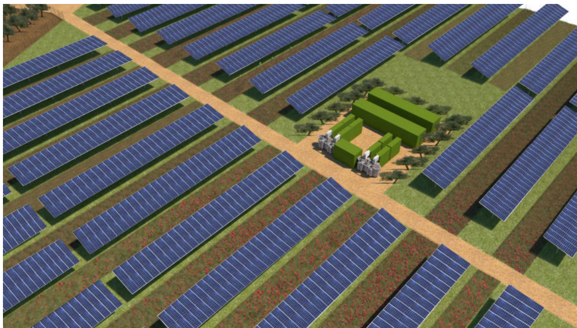
Fig. 5 - Vista cabine dal basso
