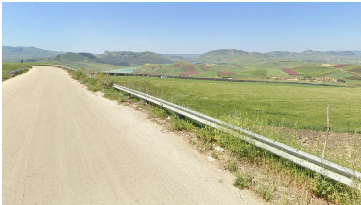
Vista 8- Stato ante-operam
