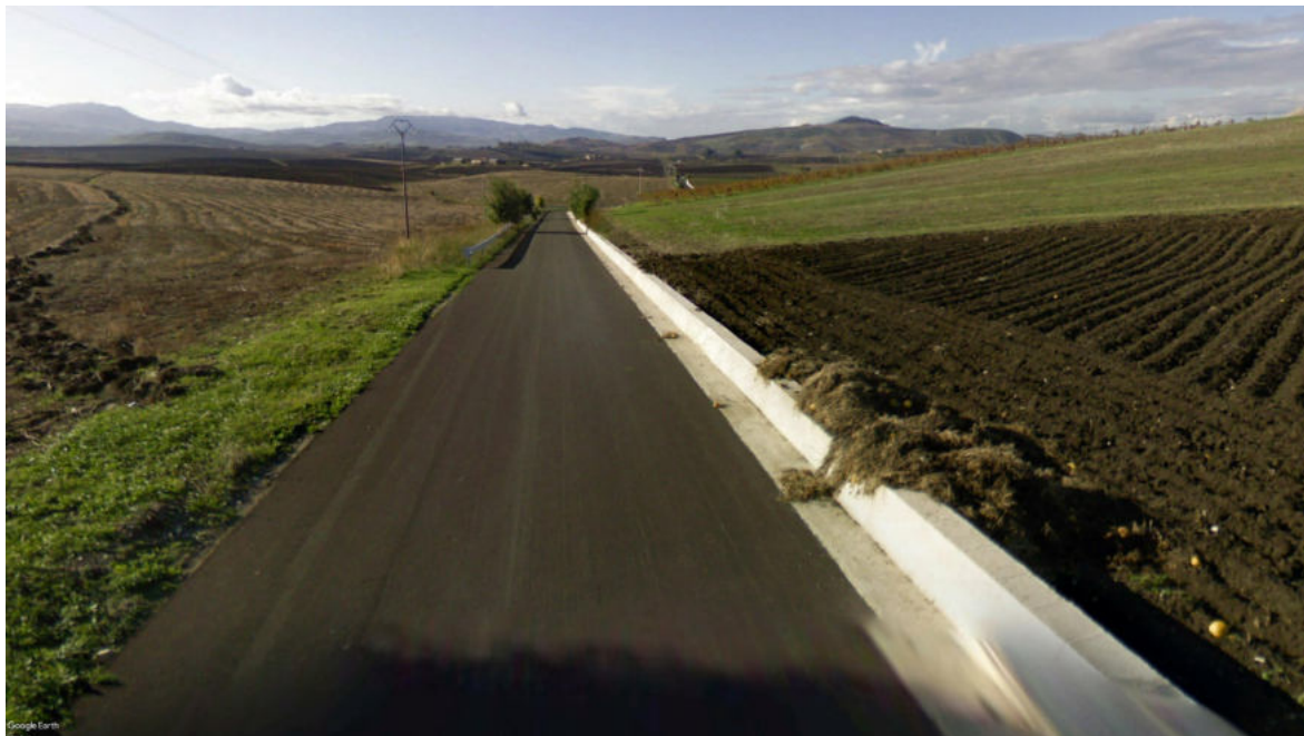
Vista 1- Stato ante-operam
