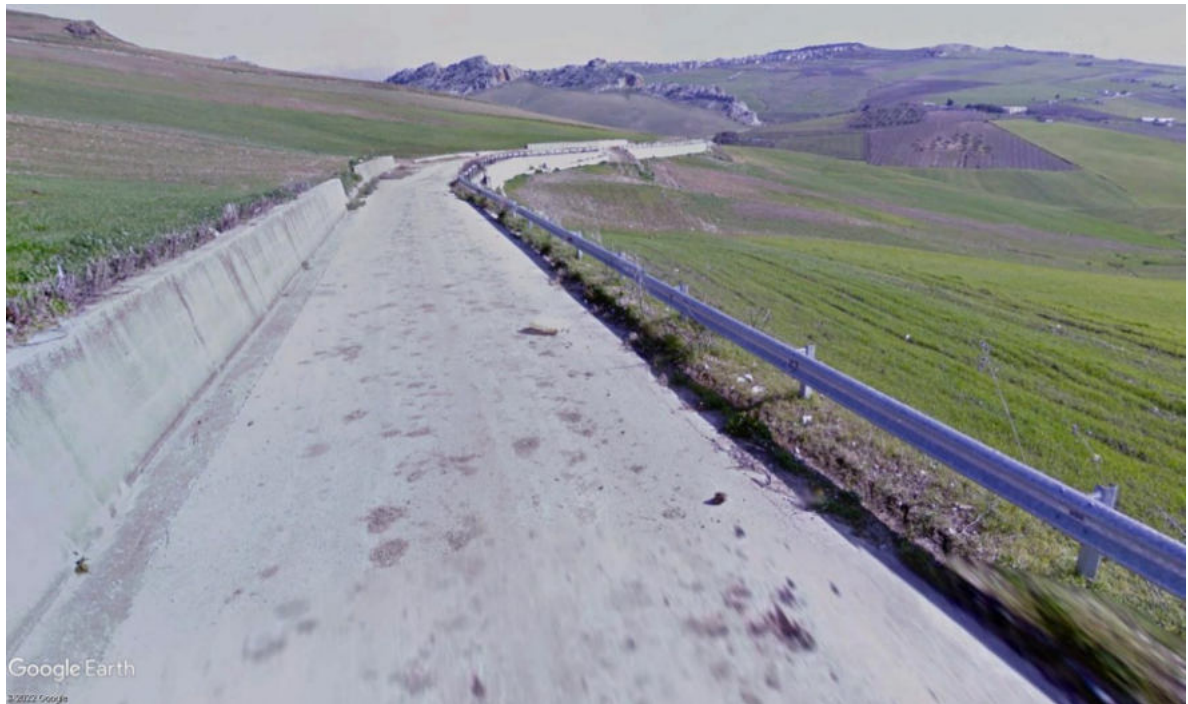
Vista 9- Stato ante-operam
