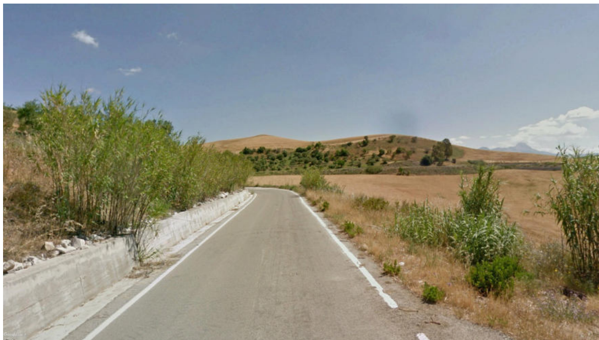
Vista 12- Stato ante-operam
