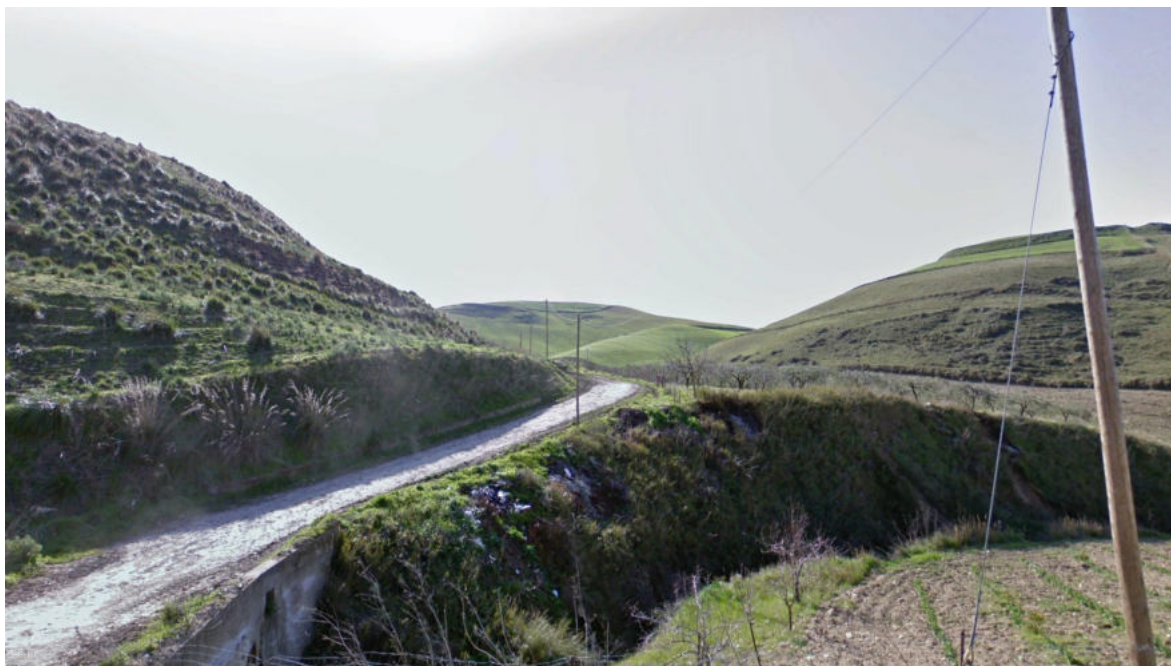
Vista 15- Stato ante-operam
