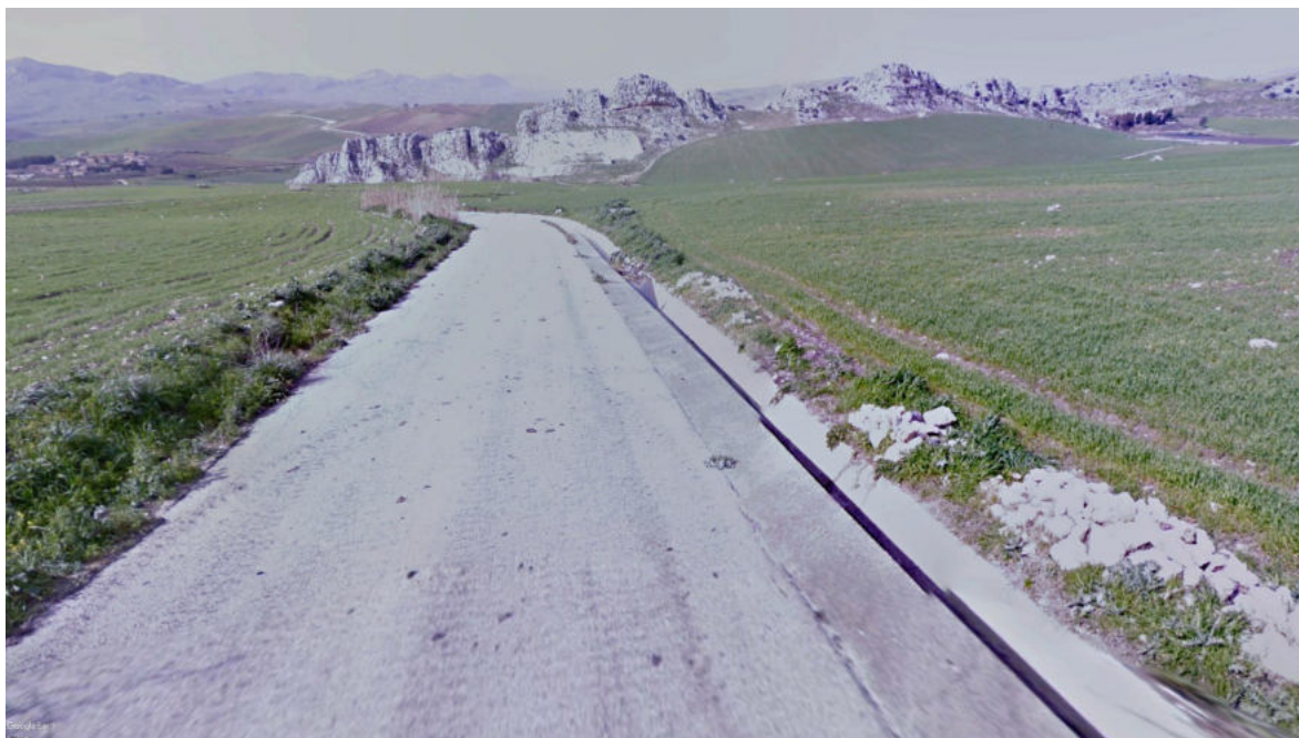
Vista 7- Stato ante-operam
