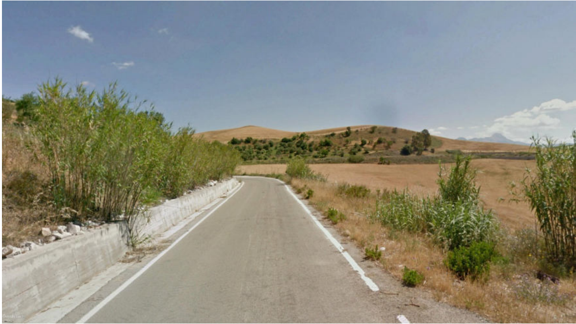
Vista 12 – Stato ante-operam
