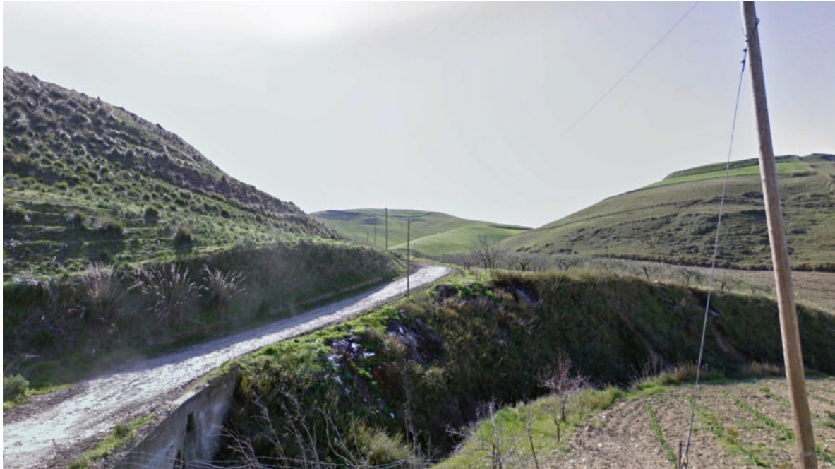
Vista 15 – Stato ante-operam
