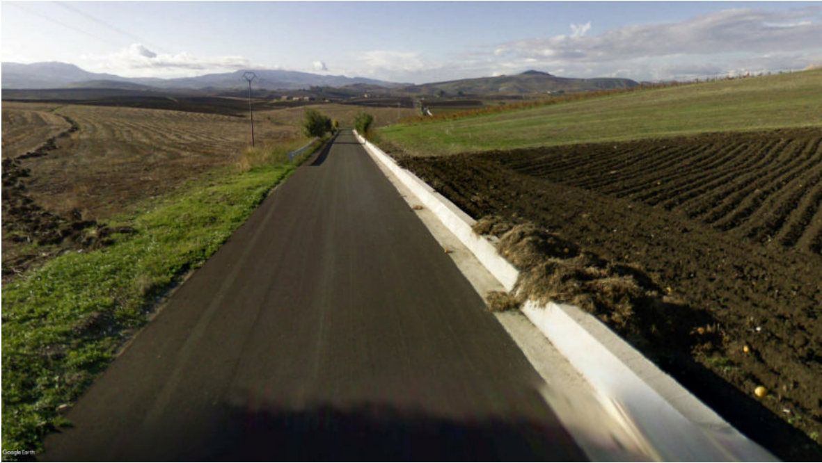
Vista 1 – Stato ante-operam
