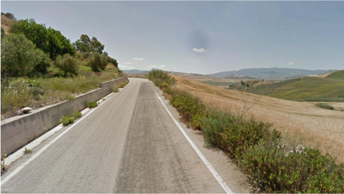
Vista 11 – Stato ante-operam
