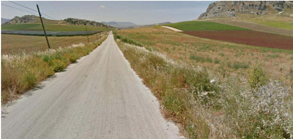
Vista 6 – Stato ante-operam
