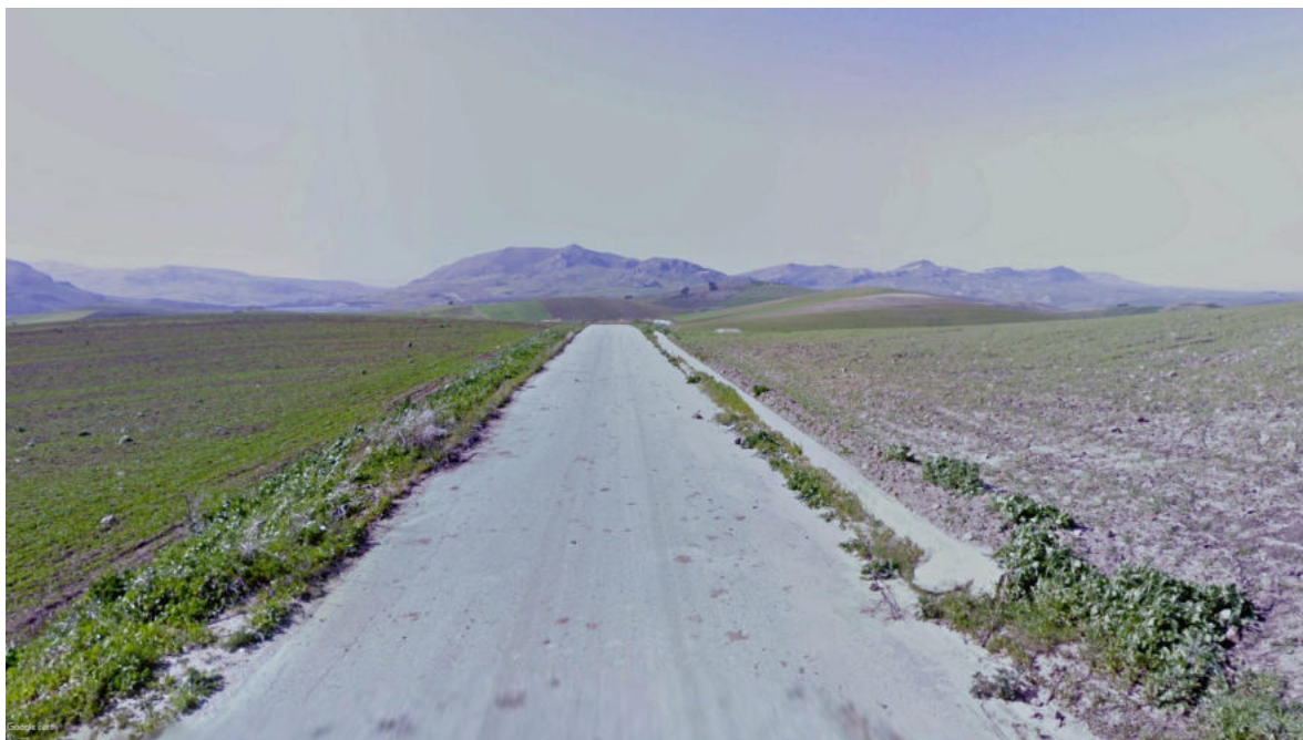
Vista 10 – Stato ante-operam
