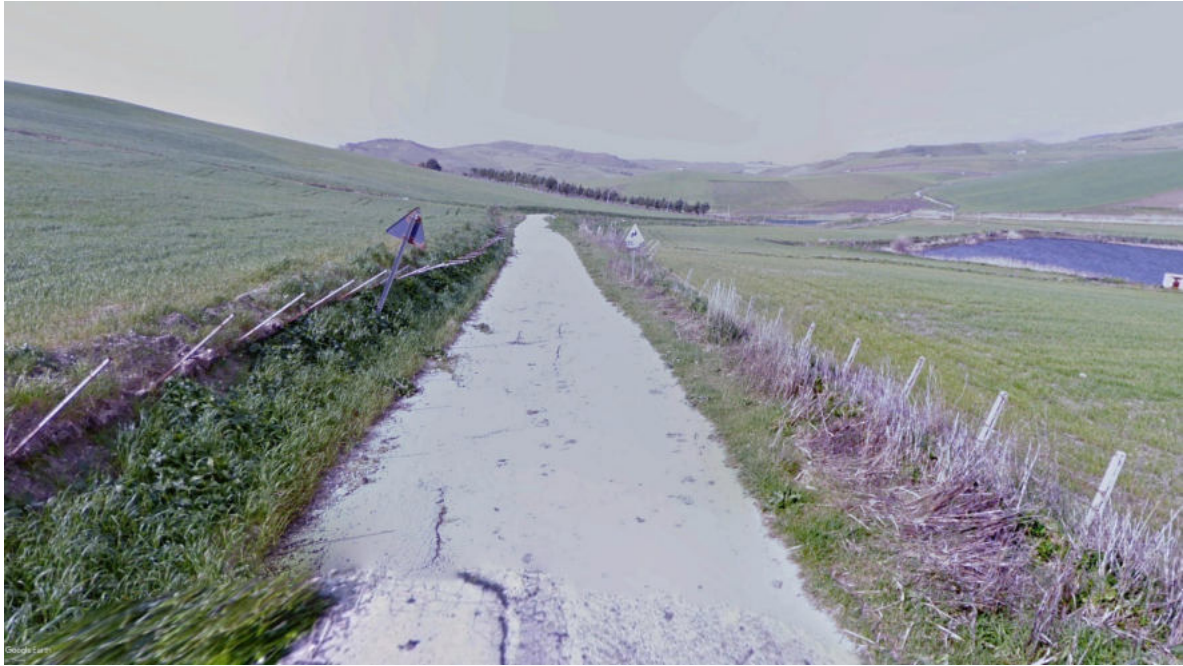
Vista 4 – Stato ante-operam
