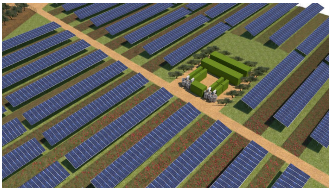
Figura 39 – Esempio vista mitigazione cabine
