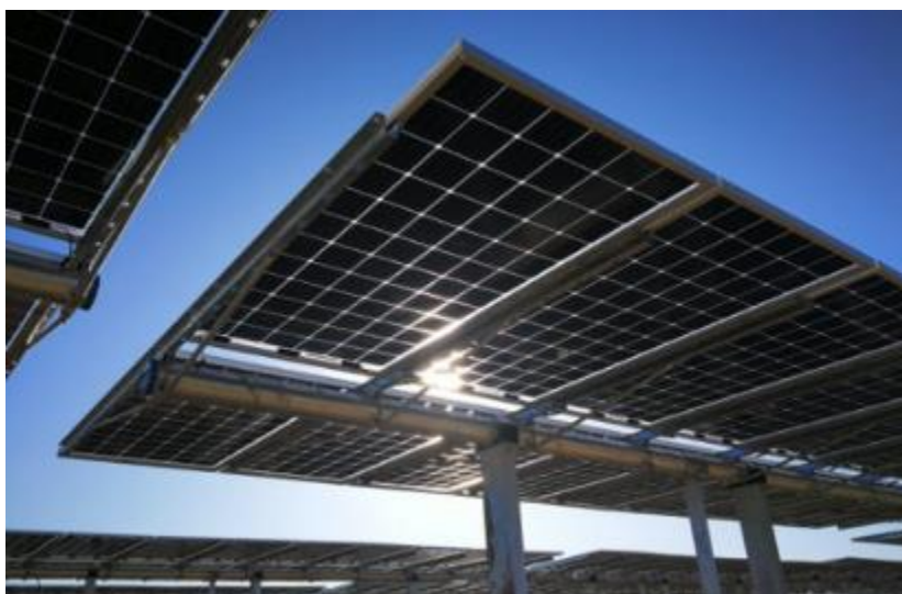
Figura 3.2: Esempio di struttura a tracker monoassiale
