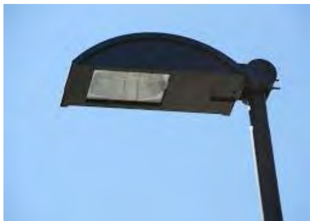
Figura 4.49: Esempio di apparecchio completamente schermato (full-cut-off).
