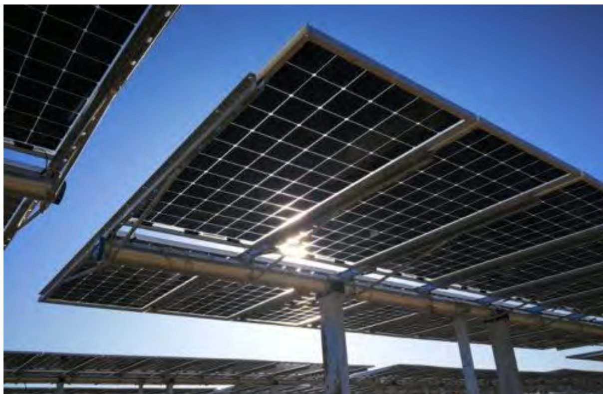
Figura 2.55 Esempio di struttura a tracker monoassiale
