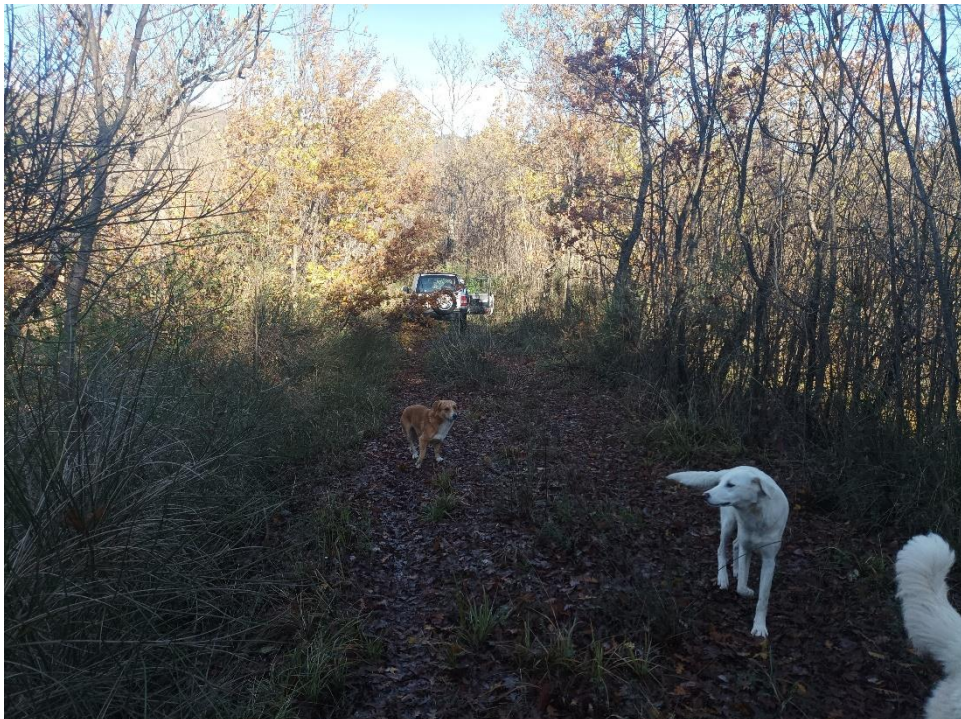
La strada forestale esistente che verrà adeguata per l'accesso alla centrale di produzione ed alle relative aree di cantiere.
