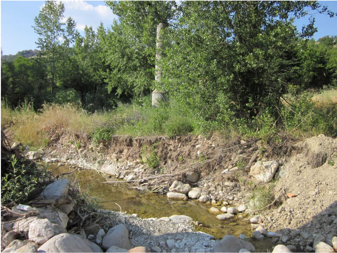
Figura 5. Evidenti segni di erosione laterale lungo il corso della fiumara di Ruoti.
