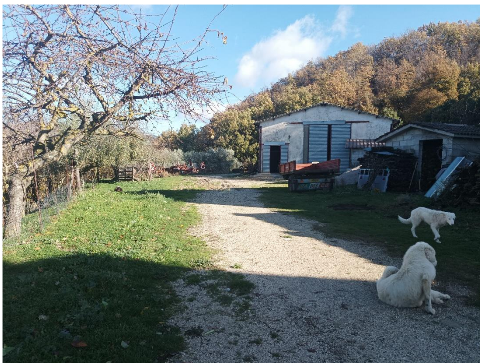
Figura 13. Il complesso di Masseria Spadola accanto al quale verrà realizzata la pista di accesso alla centrale interrata e dal quale parte la pista forestale esistente (vedi immagini successive).
