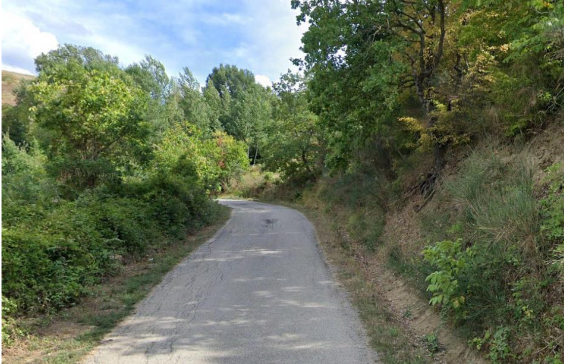
Figura 14. Tratto in cui la condotta forzata sottopassa la strada poderale esistente.
