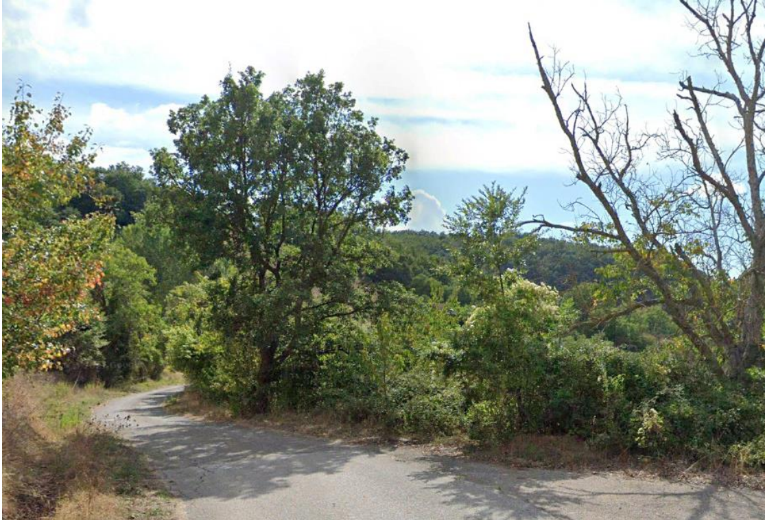
Figura 27. Il tratto della strada podereale per Avriola (Comune di Ruoti) in cui verrà posato il cavidotto interrato.
