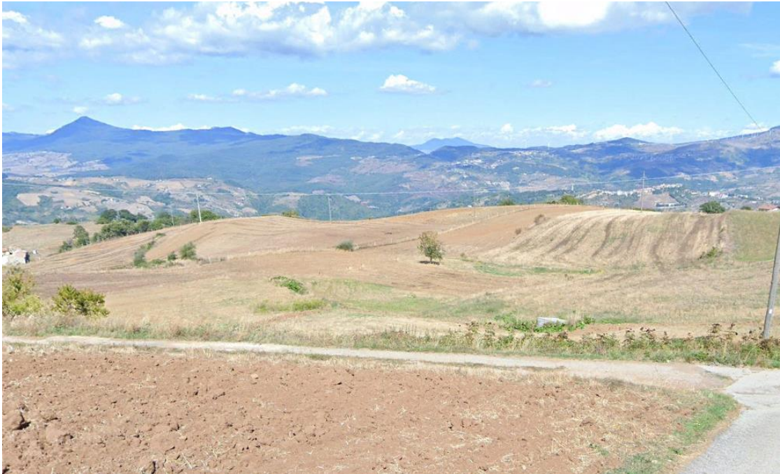
Figura 18. Tratto in cui la condotta forzata sottopassa la strada poderale esistente.
