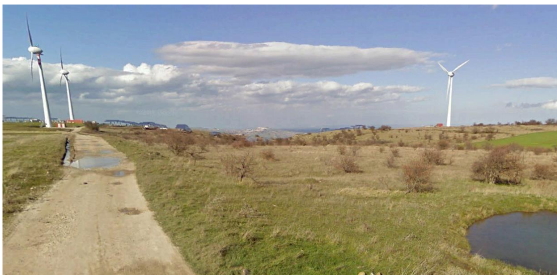
Figura 36. L'area in cui è prevista la realizzazione della SSE a servizio dell'impianto nel Comune di Vaglio.
