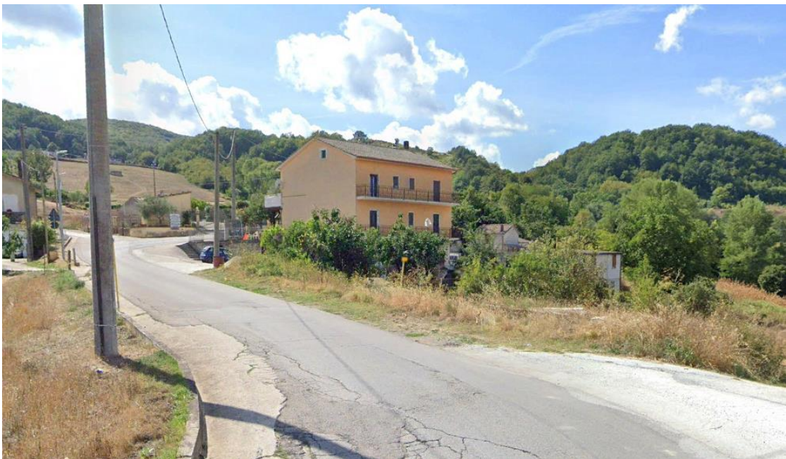
Figura 28. La strada in località Contrada Croce sotto la quale verrà posato il cavidotto.
