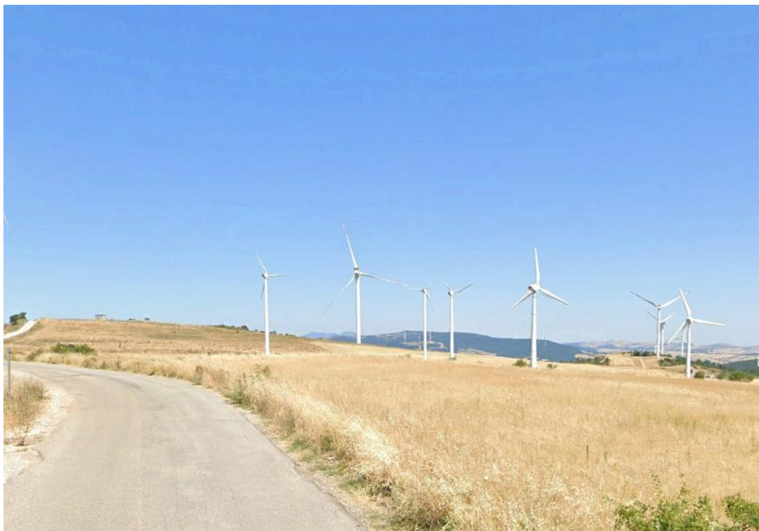
Figura 35. Sito in cui verrà realizzato il traliccio Nr. 8 lungo la SP10.
