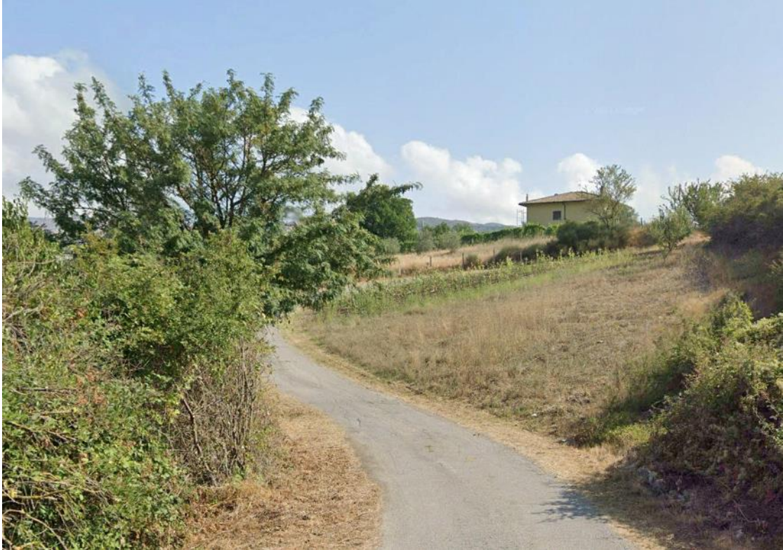
Figura 31. L'area che ospiterà la stazione di transizione cavo –aereo ed il traliccio Nr. 58 da cui partirà l'elettrodotto aereo.
