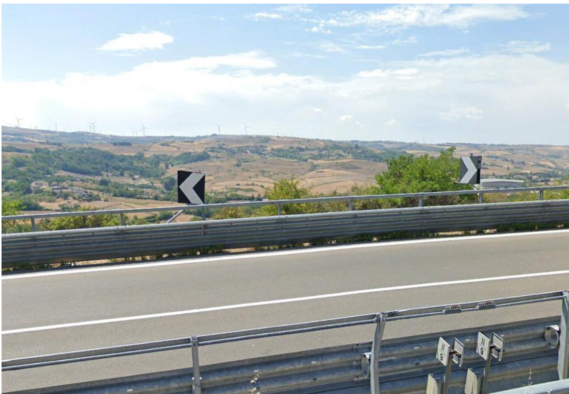
Figura 34. Superamento della SS658 in contrada San Francesco.
