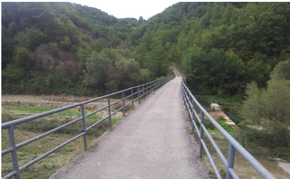
Figura 12. Il ponte stradale sulla Fiumara di Avigliano che verrà utilizzato per l'accesso alla centrale di produzione.
