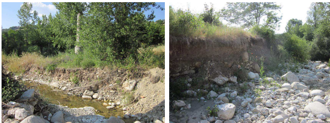
Figura 19. L'attività torrentizia della Fiumara è visibile dalle condizioni dell'alveo
