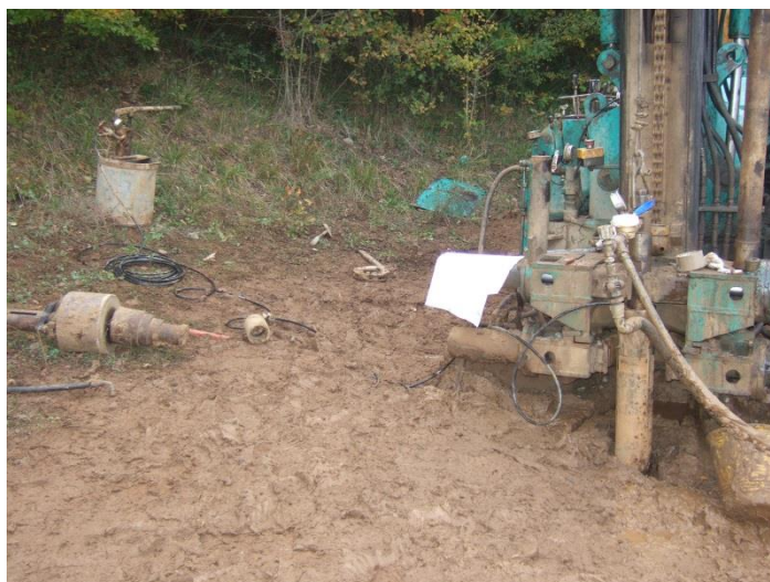
Figura 16 – Fase di esecuzione della prova in foro tipo Lugeon
