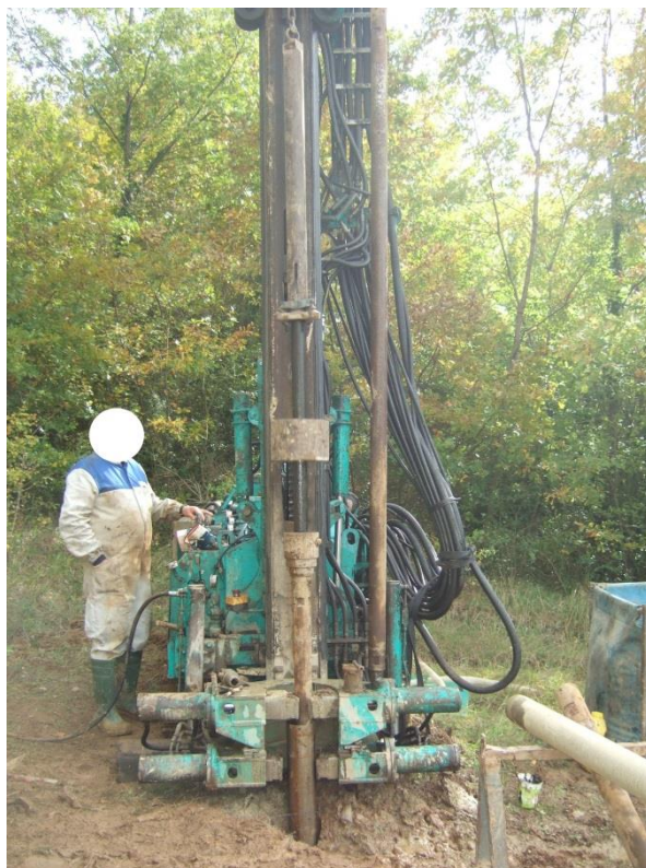
Figura 14: Fase di esecuzione della prova penetrometrica dinamica S.P.T.
