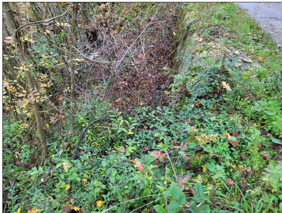
Foto 19 – Veduta dell'alveo del corso d'acqua demaniale a valle dell'attraversamento stradale.
