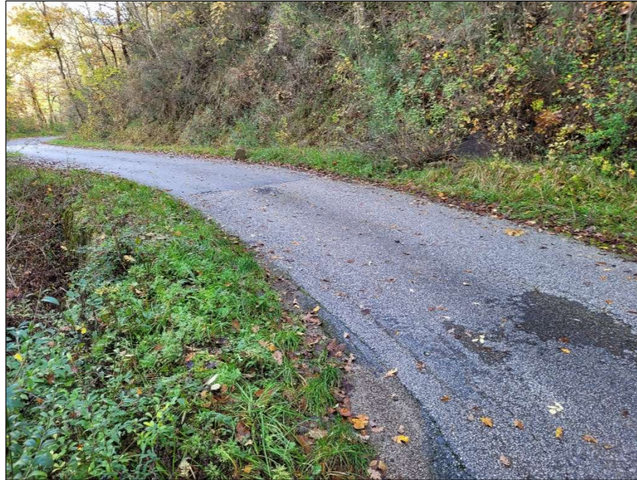
Foto 18 - Attraversamento stradale del corso d'acqua demaniale guardando verso Ovest.
