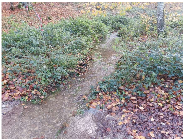
Foto 44 – Veduta dell'alveo del corso d'acqua demaniale in corrispondenza dell'attraversamento.
