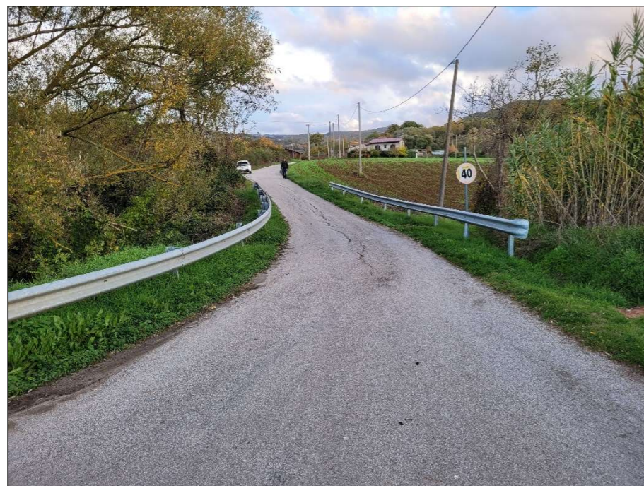
Foto 4 - Vista strada pubblica attraversamento. Vista verso est.
