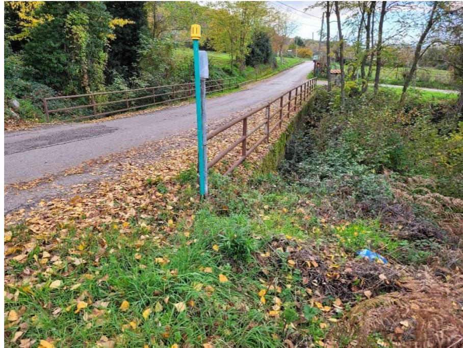
Foto 6 – Vista di via Contrada Croce nel punto di attraversamento del corso d’acqua demaniale, guardando verso Ovest.
