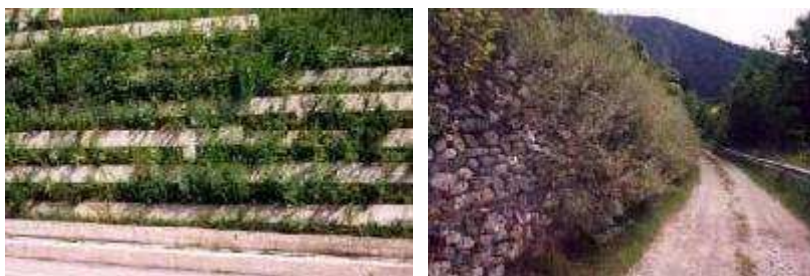
Figura 11. Esempi di muri cellulari e gabbionate rinverdite.
