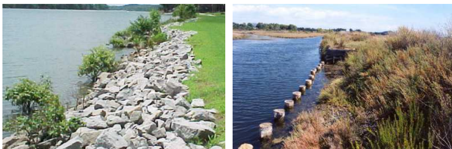
Figura 5. Esempi di scogliere, terrazzi vivi rinforzati o palificate in legno vivo.
