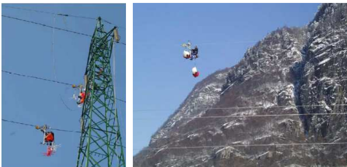
Figura 7. Esempi di dispositivi a sfera installati sulle linee ad alta tensione in ambito montano.
