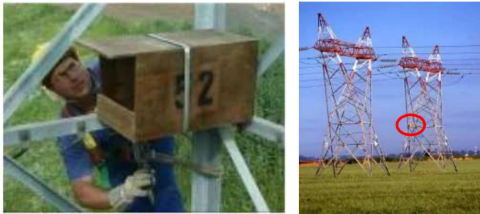
Figura 8. Esempi di nidi artificiali per l'avifauna installabili nel terzo medio ed inferiore dei tralicci del nuovo elettrodotto.
