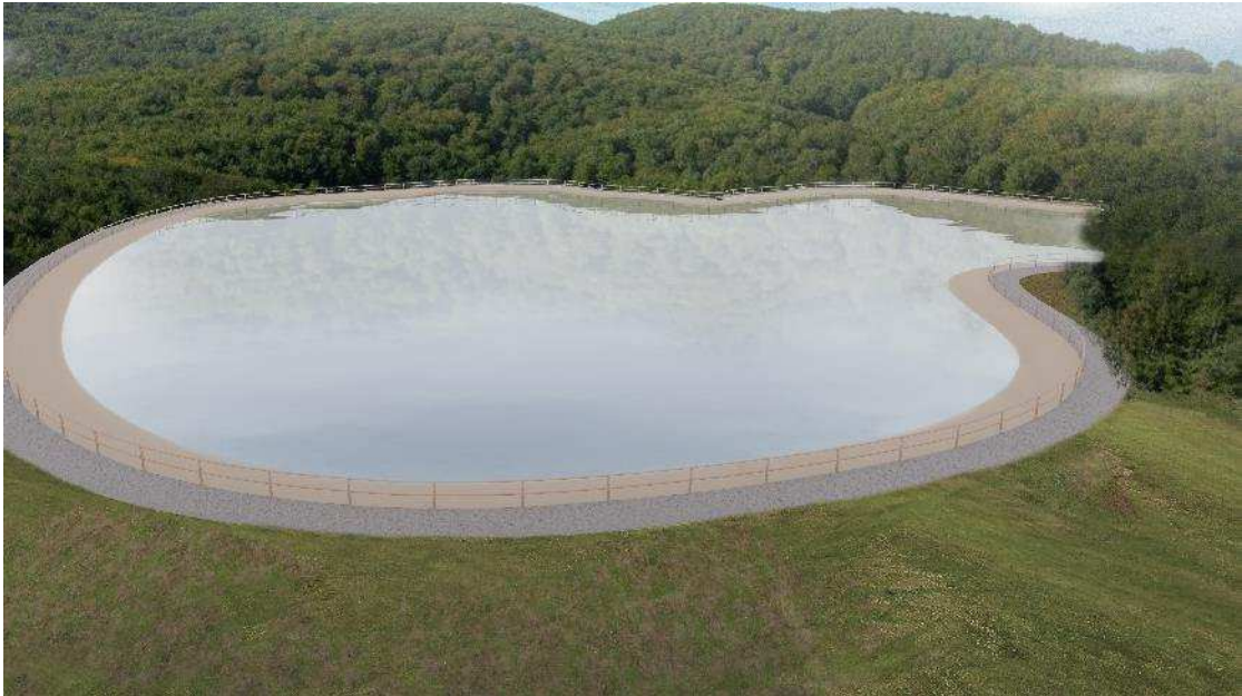
Figura 129. Rendering dello stato di progetto del bacino di monte visto dal recettore L. Si notano le arginature dell'invaso realizzate con pendenze dolci e rinverdite.
