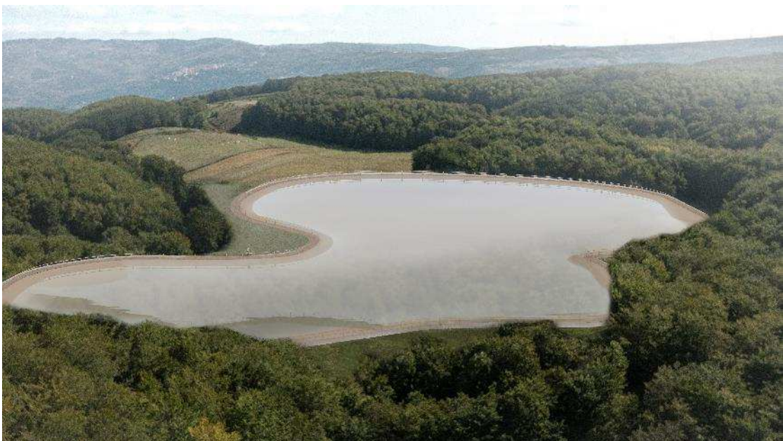
Figura 130. Rendering dello stato di progetto del bacino di monte visto dal recettore M. Si notano le arginature dell'invaso realizzate con pendenze dolci e rinverdite.
