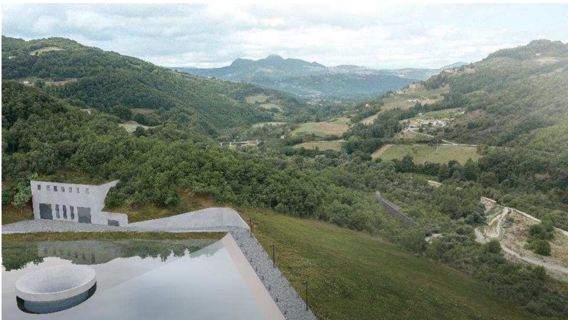
Figura 131. Rendering dello stato di progetto di parte della diga dell'invaso di valle con le opere ad esso annesse (vista dal recettore N1), la centrale è realizzata con tipiche colorazioni del posto e parzialmente interrata grazie alla creazione di una collina di mitigazione che andrà a ridurre anche l'impatto visivo delle opere di scarico.
