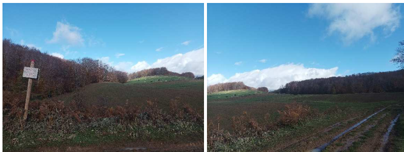
Figura 140. Le aree destinate ad occupare il cantiere di monte e successivamente utilizzate per i previsti interventi di livellamento morfologico e di riqualificazione fondiaria.
