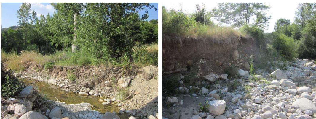
Figura 37. L'attività torrentizia della Fiumara è visibile dalle condizioni dell'alveo
