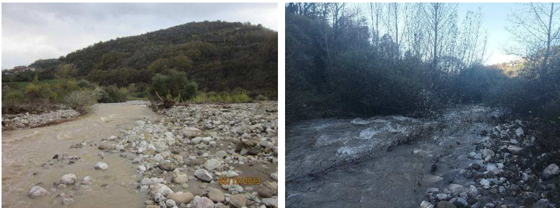
Figura 39. La Fiumara presso lo sbocco con la Fiumara di Avigliano nel dicembre 2013 e nel novembre 2022.
