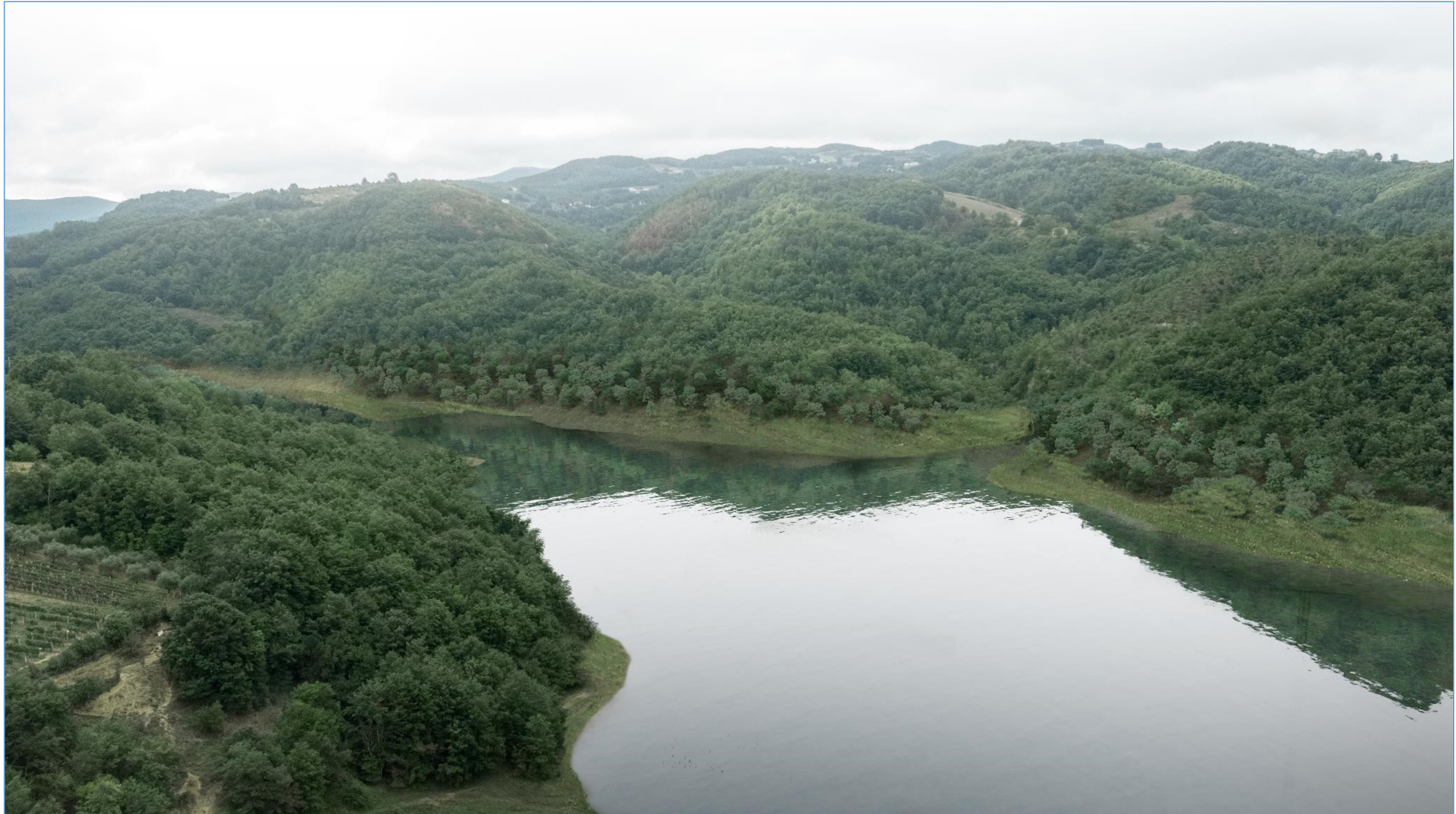
Figura 20. Da questo recettore è visibile la parte a Est del bacino di valle. L'innesto sui versanti della Fiumara di Ruoti sarà per quanto possibile rivegetato con essenze arboree e arbustive locali; il taglio delle piante e della vegetazione lungo le sponde del nuovo invaso sarà limitato ad una fascia ridotta di un massimo di 5 m e le sponde stesse non saranno rimodellate in modo sostanziale.
