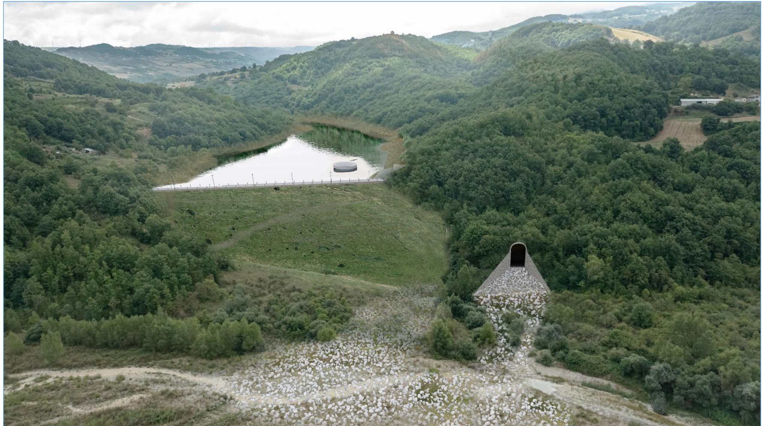
Figura 16. Il bacino di valle è visibile al recettore I ma l'impatto sul paesaggio verrà limitato grazie al rinverdimento dello sbarramento in terra che sarà realizzato con pendenze non elevate. Per quanto riguarda le opere di scarico, esse saranno inserite nel versante esistente e dopo i necessari lavori di sbancamento e di stabilizzazione delle scarpate, la struttura in cemento armato verrà chiusa con una soletta in c.a. e l'intera struttura sarà coperta di terreno, la cui superficie sarà rinverdita. Da questo recettore, la visibilità della centrale di produzione è mascherata grazie all'effetto della rimodellazione del terreno e dei rinverdimenti che saranno effettuati.
