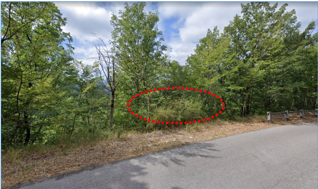
Figura 14. La parte superiore dell'edificio della centrale è fuori terra ma la percezione della sua presenza è molto ridotta. La presenza della diga quasi non si percepisce perché è mascherata dalla vegetazione.
