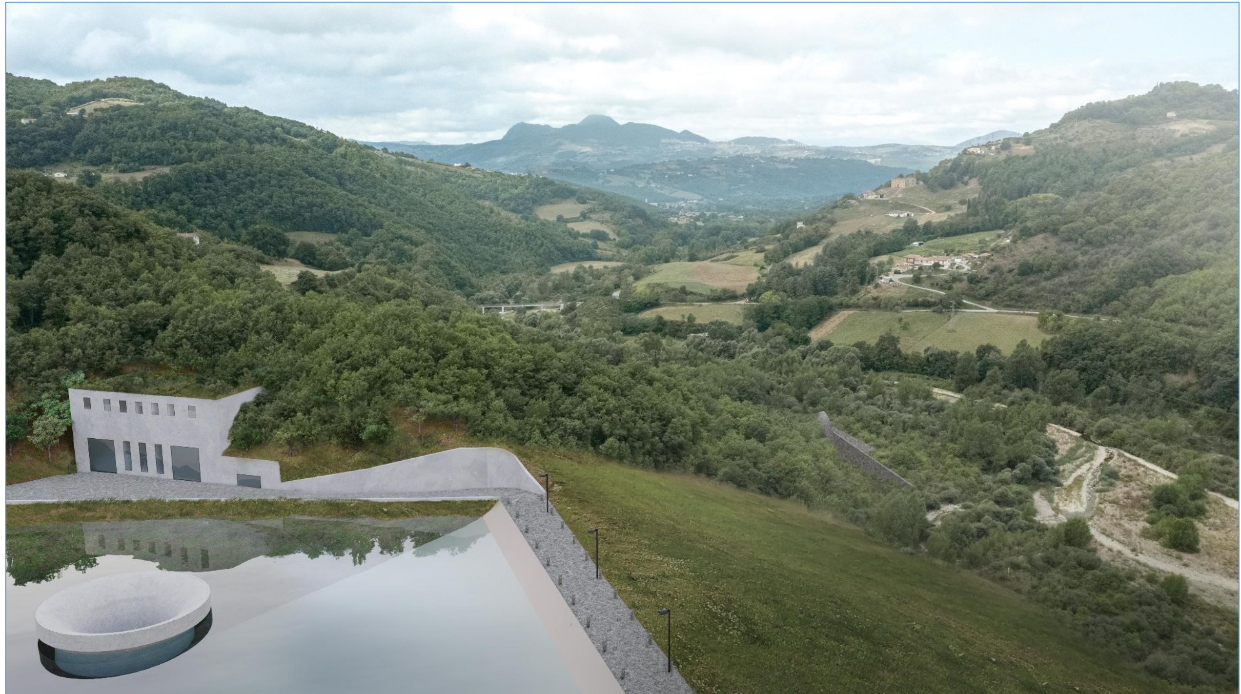
Figura 19. Da questo recettore è visibile il bacino di valle con la centrale di produzione e le opere di scarico. L'impatto del progetto verrà mitigato realizzando le opere parzialmente interrato e utilizzando mascheramenti vegetazionali per le parti che rimangono fuori terra. Inoltre, per le strutture visibili da questo recettore si utilizzeranno materiali da costruzione con colorazioni che richiamano le caratteristiche del territorio tipico circostante.
