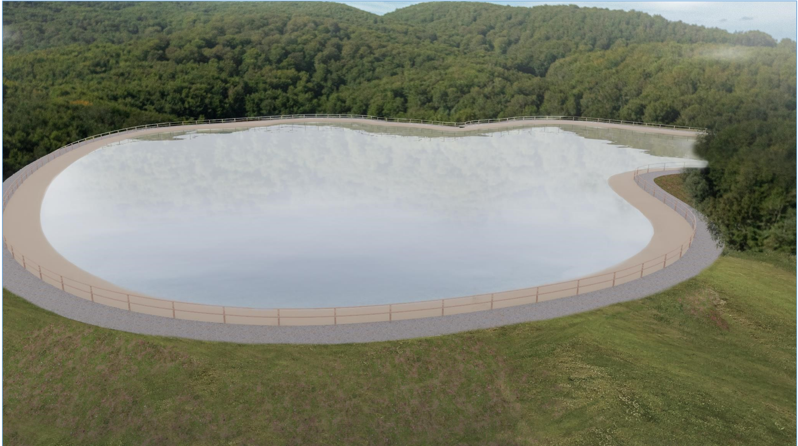
Figura 17. Il bacino di monte è percepibile dal recettore L, ma l'impatto sarà mascherato grazie alle non elevate pendenze con cui si realizzeranno le scarpate dei paramenti di valle delle arginature ed il relativo rinverdimento.
