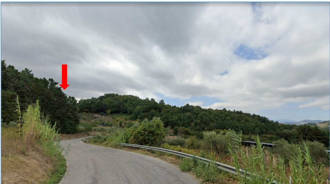
Figura 15. Il bacino di valle e la centrale elettrica non sono percepibili dall'osservatore H data la distanza che intercorre tra il recettore e le opere e perché sono mascherate dalla vegetazione e topografia.
