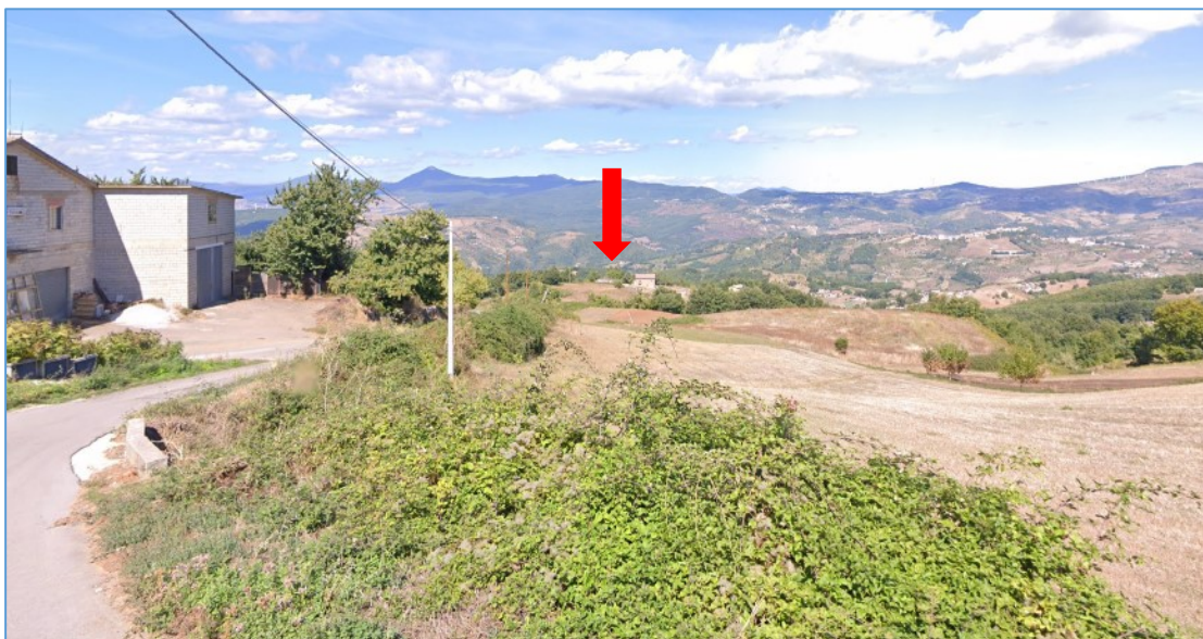
Figura 8. Il bacino di valle e la centrale elettrica non sono percepibili dall'osservatore A data la distanza che intercorre tra il recettore e le opere e perché sono mascherate dalla vegetazione e topografia.
