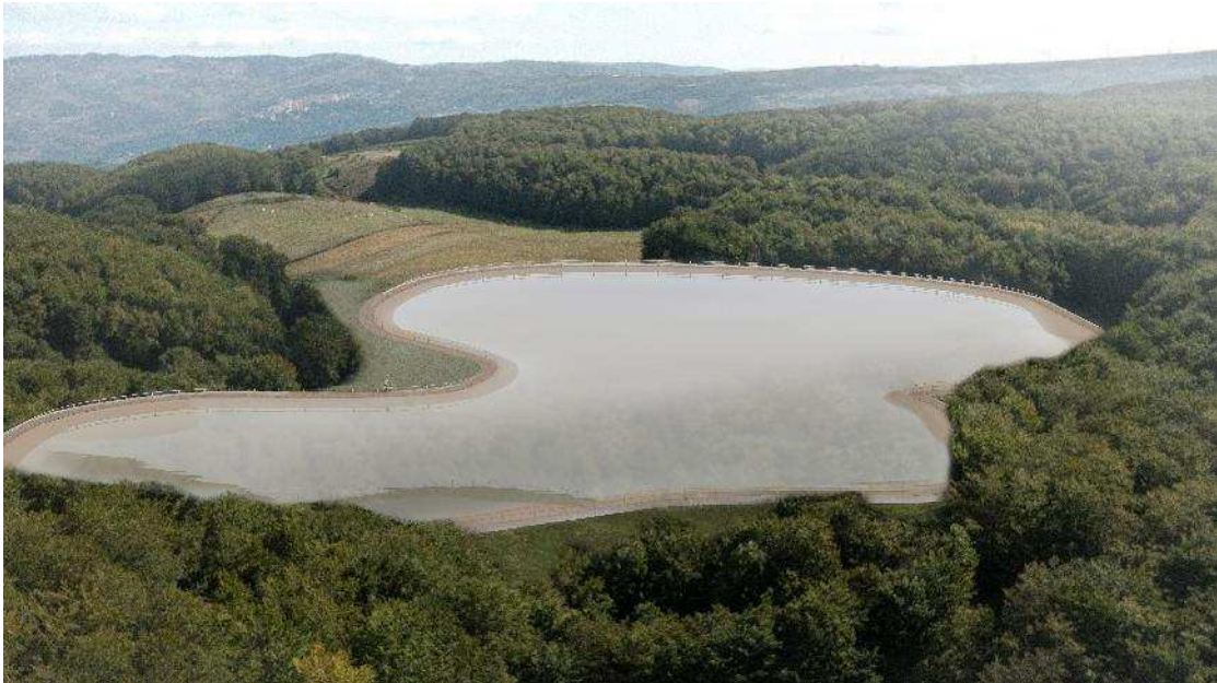
Figura 50. Rendering dello stato di progetto del bacino di monte visto dal recettore M. Si notano le arginature dell'invaso realizzate con pendenze dolci e rinverdite.
