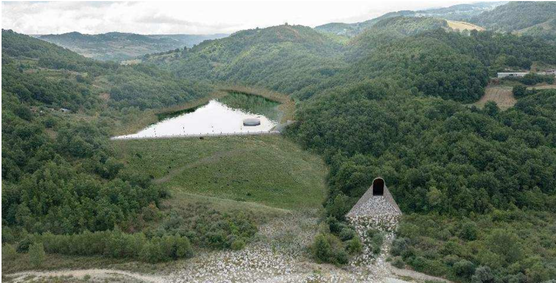
Figura 52. Stato di progetto dell'invaso di valle con le opere annesse (vista dal recettore I). La centrale non si percepisce grazie alle misure di mitigazione previste. il paramento della diga rinverdito presenta pendenze dolci. Lo scarico sarà inserito nel versante esistente e si noterà solamente lo sbocco nella fiumara.
