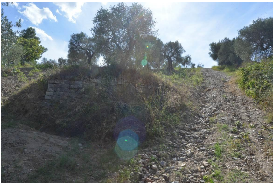
Strada non percorribile
