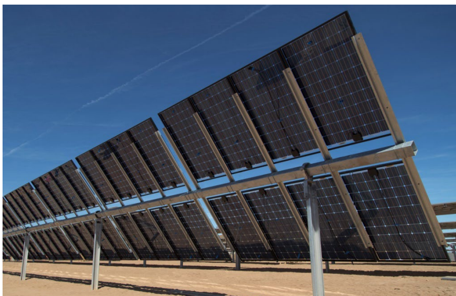
Figura 5-2 – Esempio di struttura + modulo FV bifacciale
